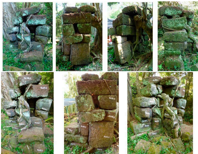
Foto 8. Esquina S-E del R6
