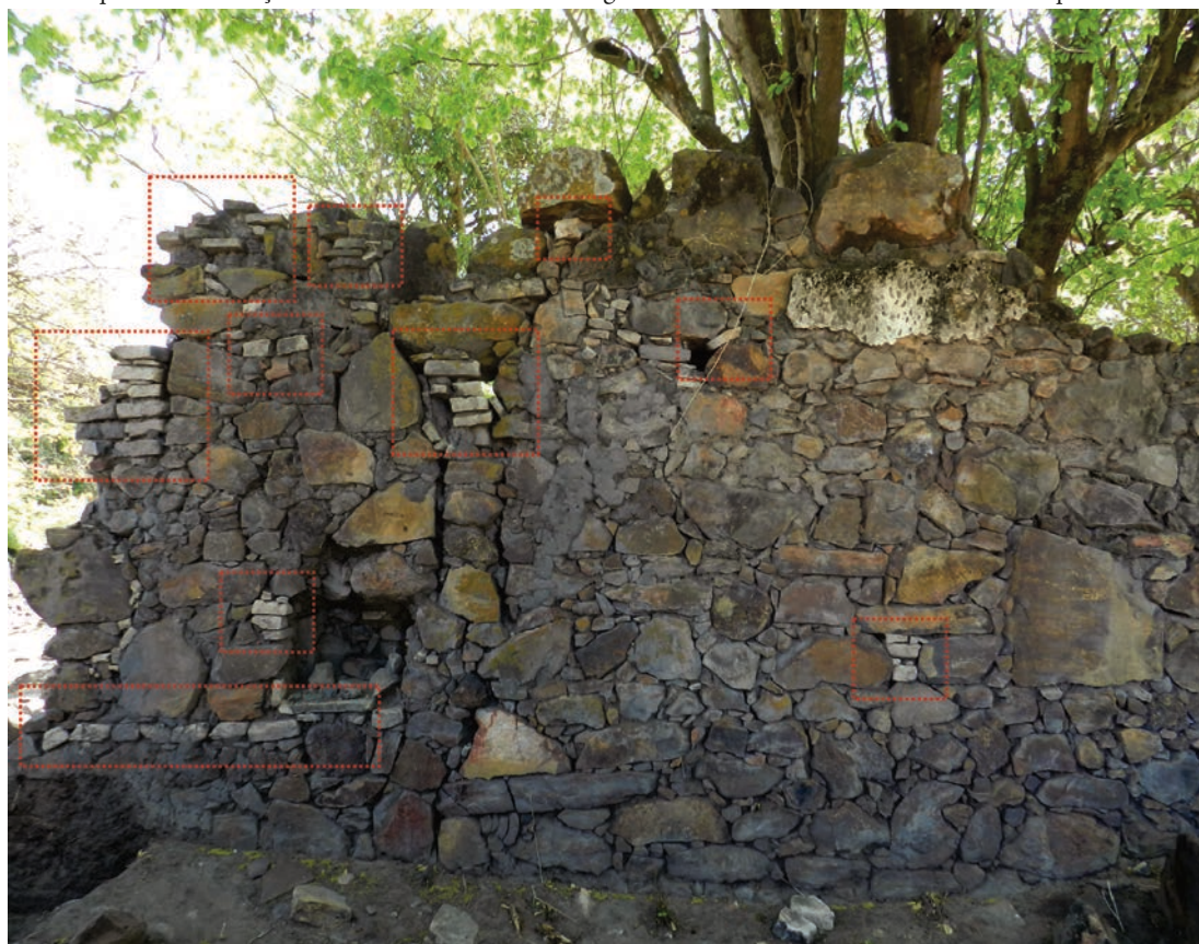
Figura 5. Organização da alvenaria mista, onde há concentração e intrusão de tijolos cerâmicos maciços para estabilização estrutural de alvenaria originalmente construída em alvenaria de pedra
