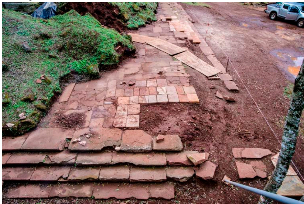
Figura 1. Los trabajos en la escalinata de la explanada al frente del Templo (2012)
