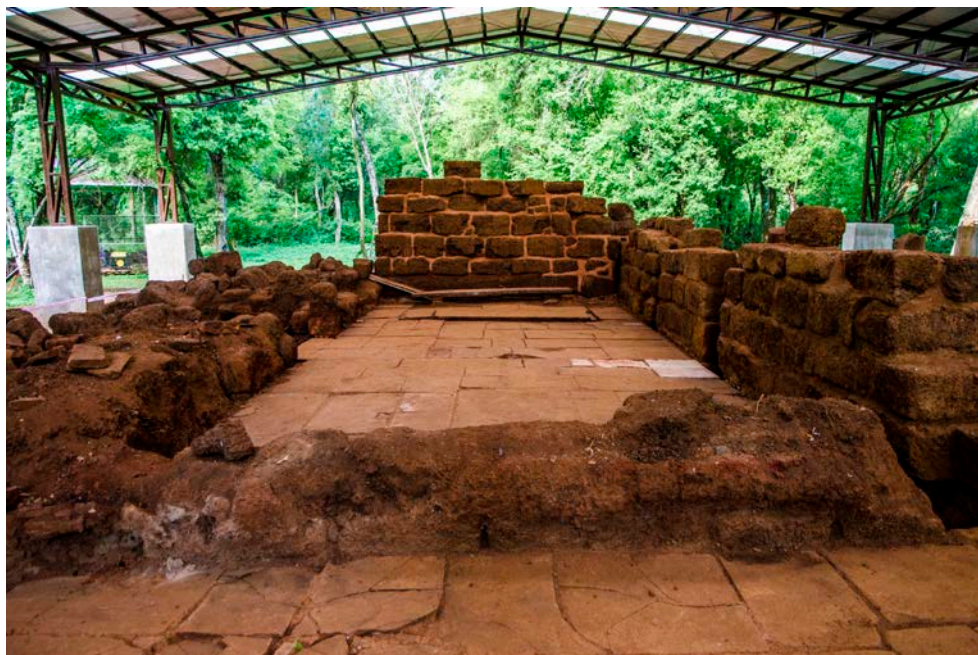
Figura 8. Vista de la capilla de Loreto hacia el altar, luego de los trabajos (2014)
