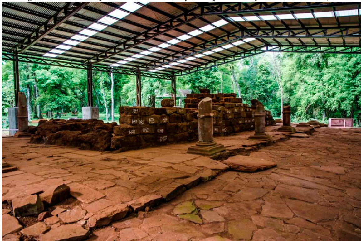
Figura 3. Vista de la Capilla de Loreto desde la explanada posterior luego de la intervención (2014)
