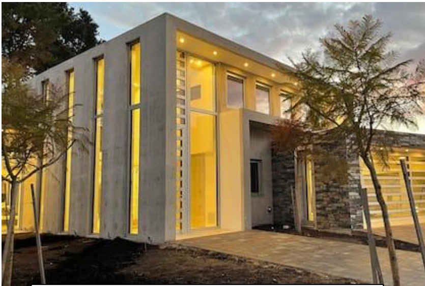
IMAGEN N° 1: “Edificio La Dianita” Vivienda unifamiliar en Mar del Plata, Buenos Aires (Argentina)
