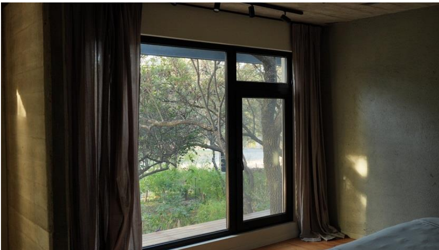
IMAGEN N° 6: vista interior de vivienda pasiva, enfoca abertura de PVC, doble vidrio hermético
