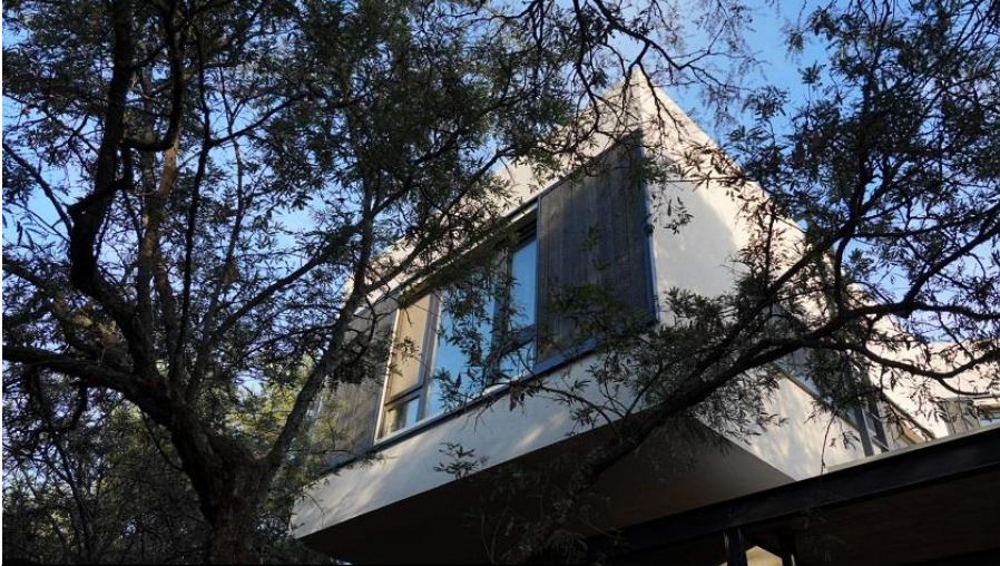
IMAGEN N° 5: vista inferior de vivienda pasiva, uso de ventilación cruzada.
