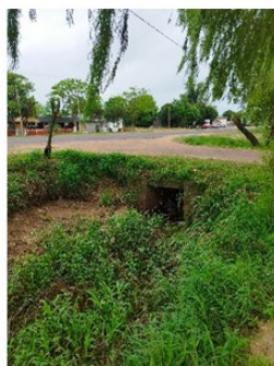
Alcantarilla longitudinal – Acceso Escuela Agrotecnica Belgrano- Prog. 4,300
