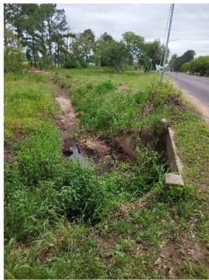
Canal abierto aguas abajo - Prog. +2,380 Av. Mortola
