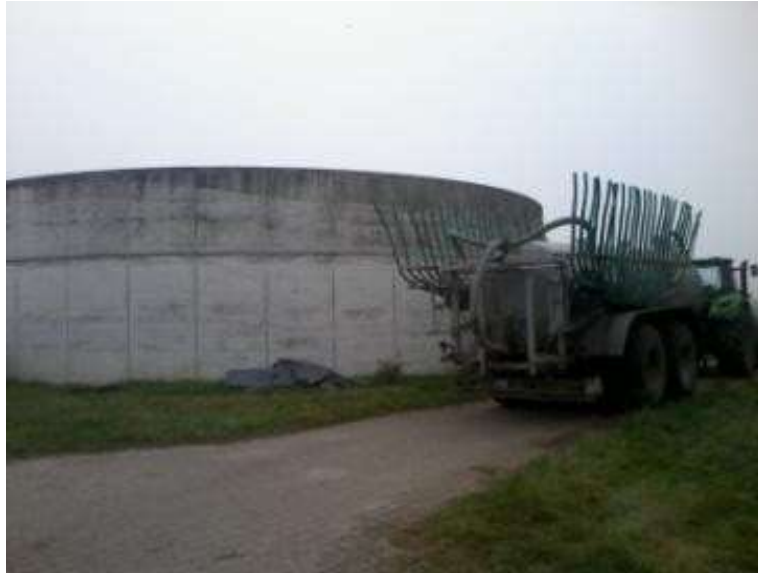
Foto 61: Almacenamiento final del digestato y tanque cisterna para su distribución en el campo
