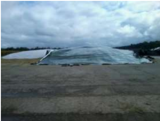
Foto 21: Colocacion completa de los cobertores
