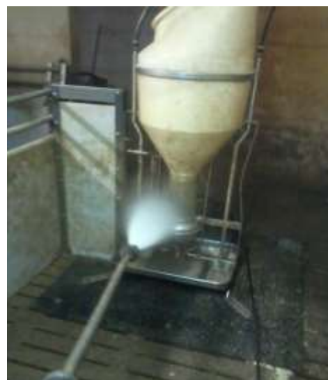
Foto 7: Limpieza y reparación de Comederos
