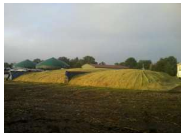
Foto 18: Silo terminado (septiembre 2014)
