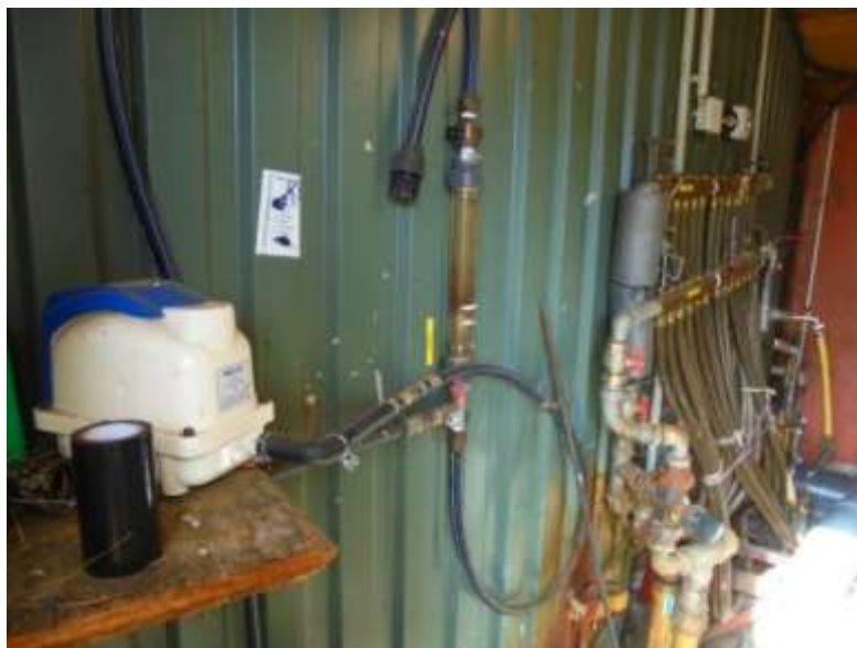
Foto 62: Mini compresor para inyectar oxígeno
