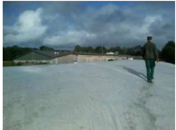
Foto 20: Inspección de los cobertores plasticos
