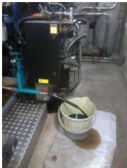
Foto 52: Cambio de aceite de los motores
