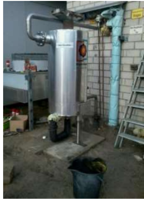
Foto 65 Instalación del filtro de carbono
