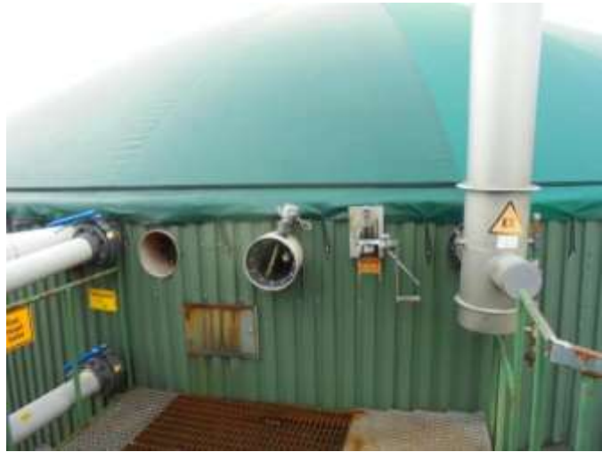
Foto 60: Ventana de inspección.
