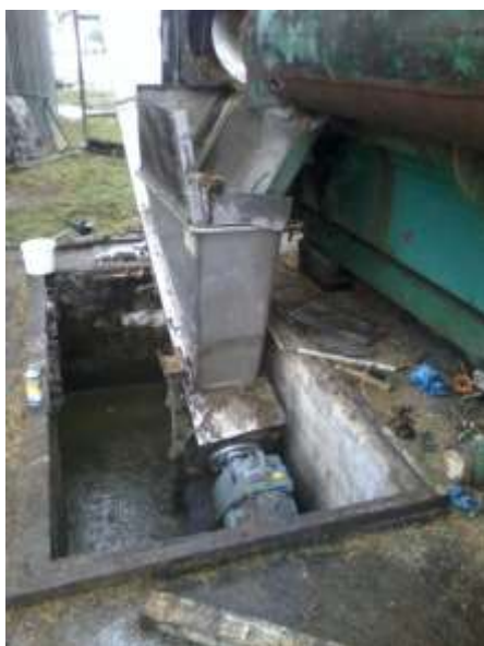
Foto 50: Reparación de motores
