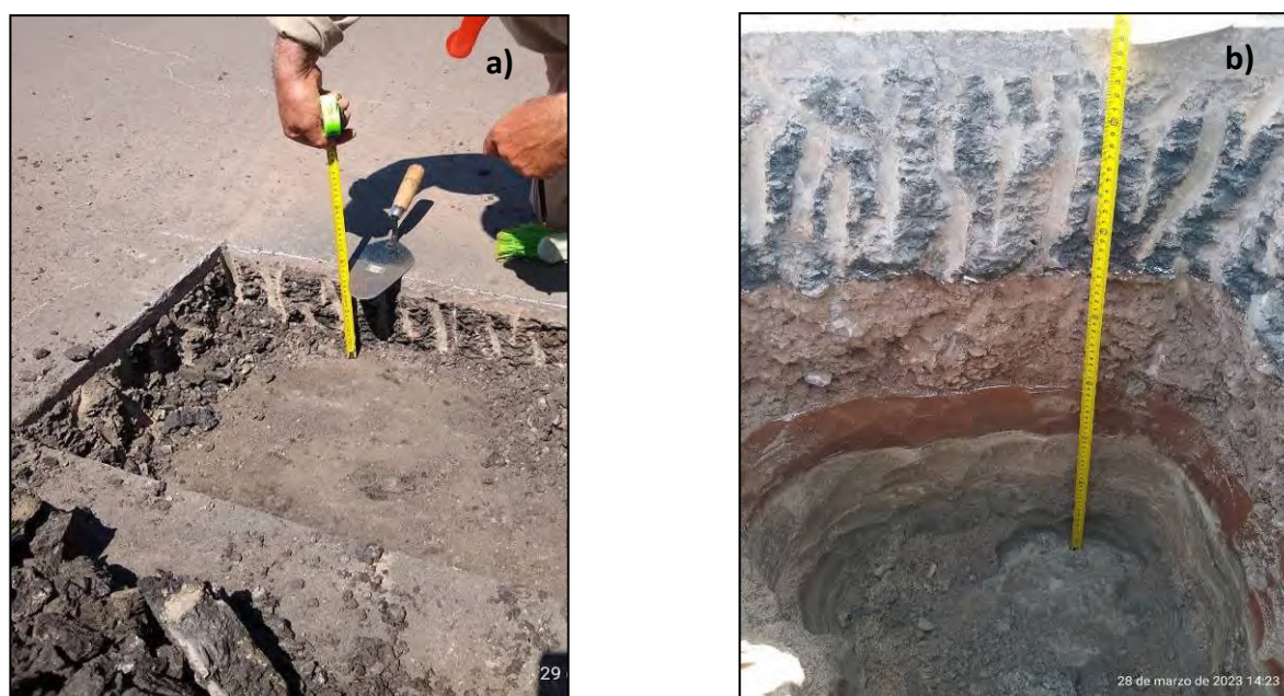
ILUSTRACIÓN II-20. a) RETIRO CAPAS ASFÁLTICAS SUPERIORES- b) PERFIL DE CAPAS PAVIMENTO
