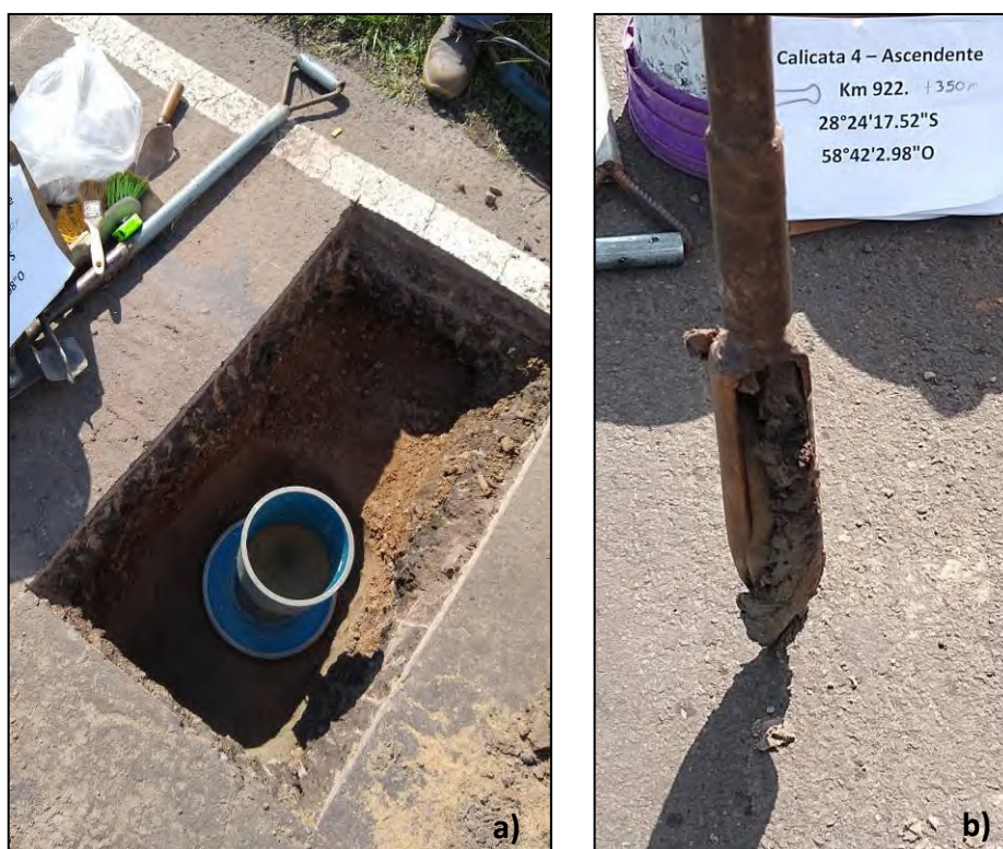
ILUSTRACIÓN II-29. KM 922+350 - CARRIL ASCENDENTE
