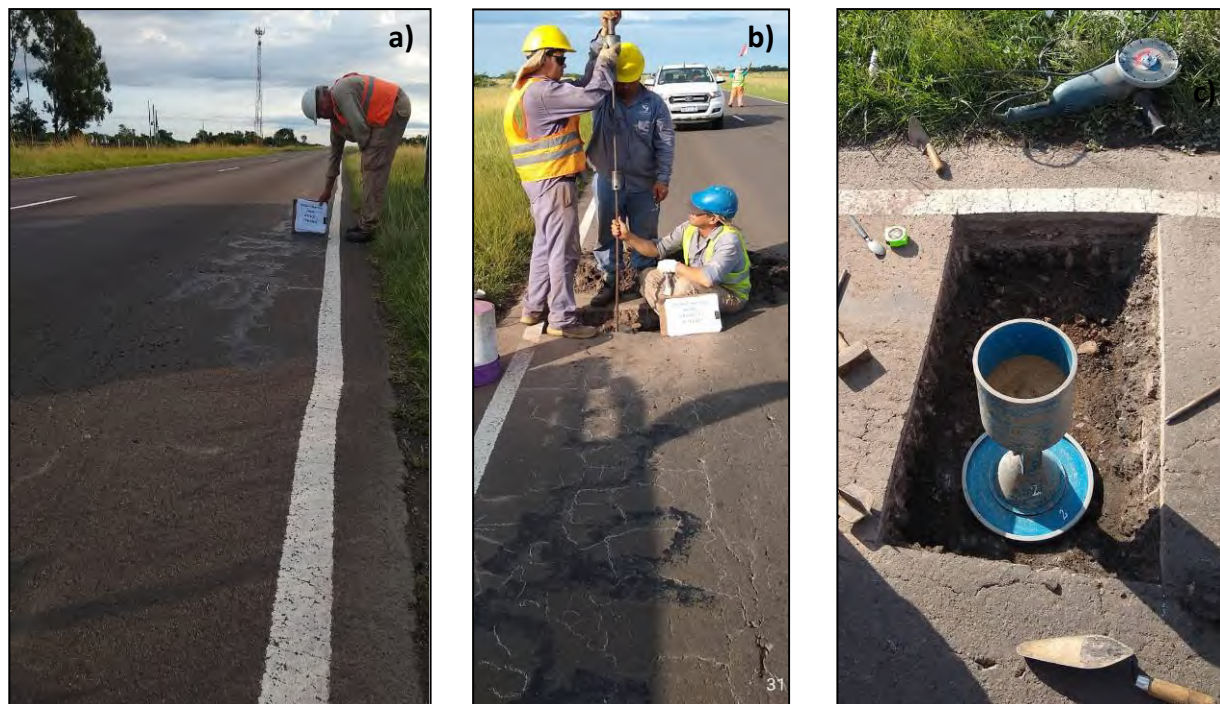
ILUSTRACIÓN II-28. CALICATA KM 922+350 - CARRIL ASCENDENTE
