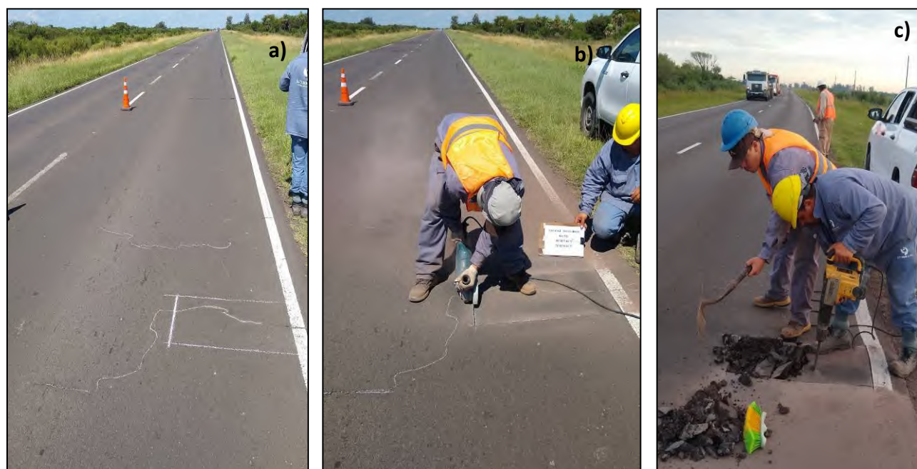
ILUSTRACIÓN II-19. a) DELIMITACIÓN DE LA CALICATA - b) ASERRADO - c) INICIO DE REMOCIÓN
