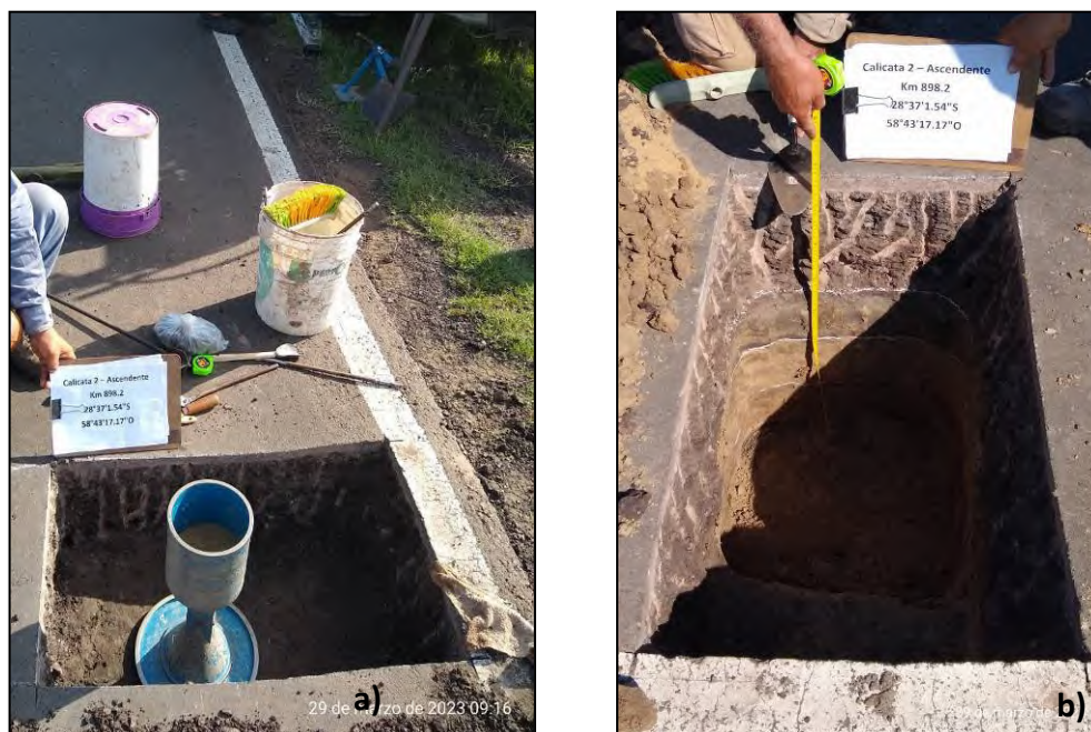
ILUSTRACIÓN II-25. CALICATA KM 898+130 - CARRIL ASCENDENTE
