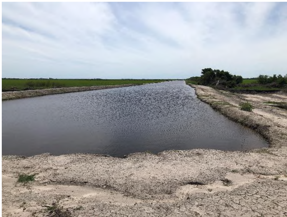
Figura N° 12: fotografía del canal principal.
