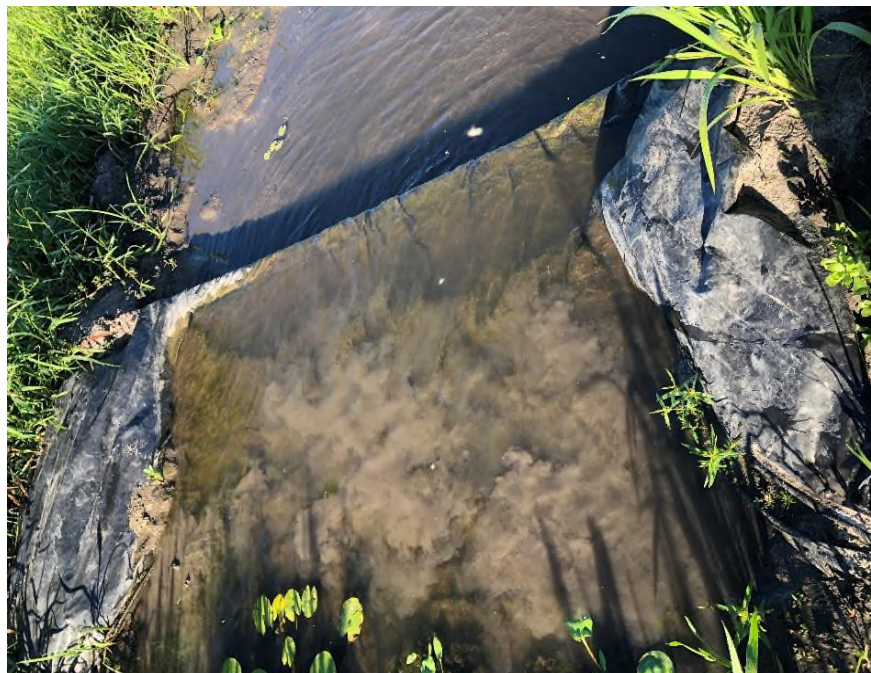
Figura N° 14: "nivel", pasando agua de un sub lote a otro".
