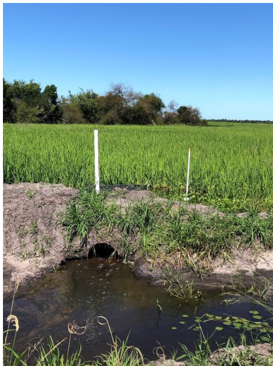
Figura N°11: Regulación correctamente de boya.
