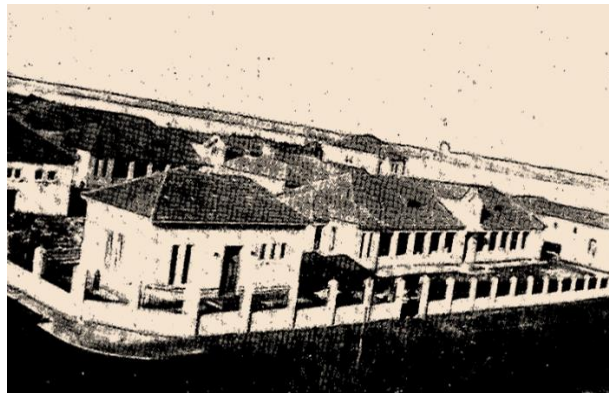
Vista de Estación Sanitaria de Paso de los Libres, construida por la empresa José S. Scarpinelli. Década del 30
