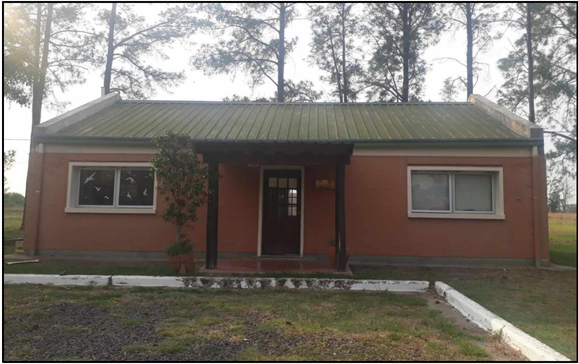
Imagen N°1: Economato: es el área del Centro en el cual funciona la cocina, se encuentra el depósito de alimentos y el sector para desayuno del personal.
