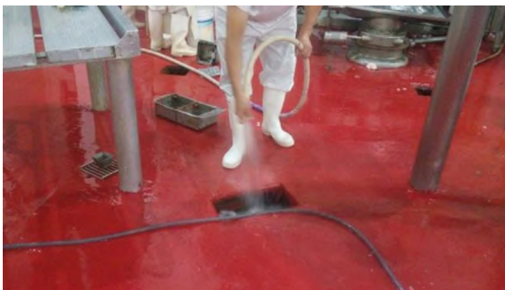
Figura 12: Limpieza del sistema de desagües
