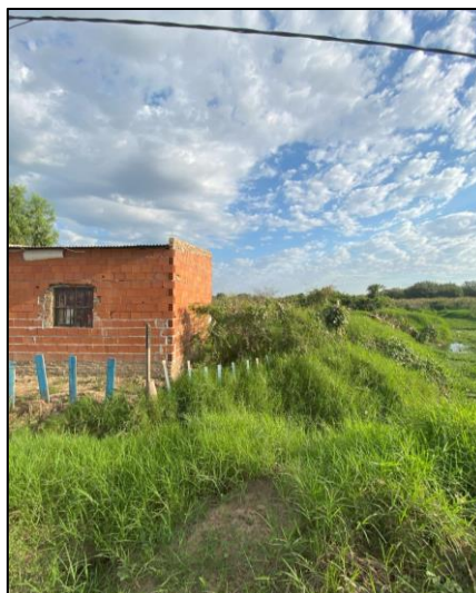
Fotografía N° 1.3: Vivienda construida sobre la margen derecha del brazo en el cruce.
