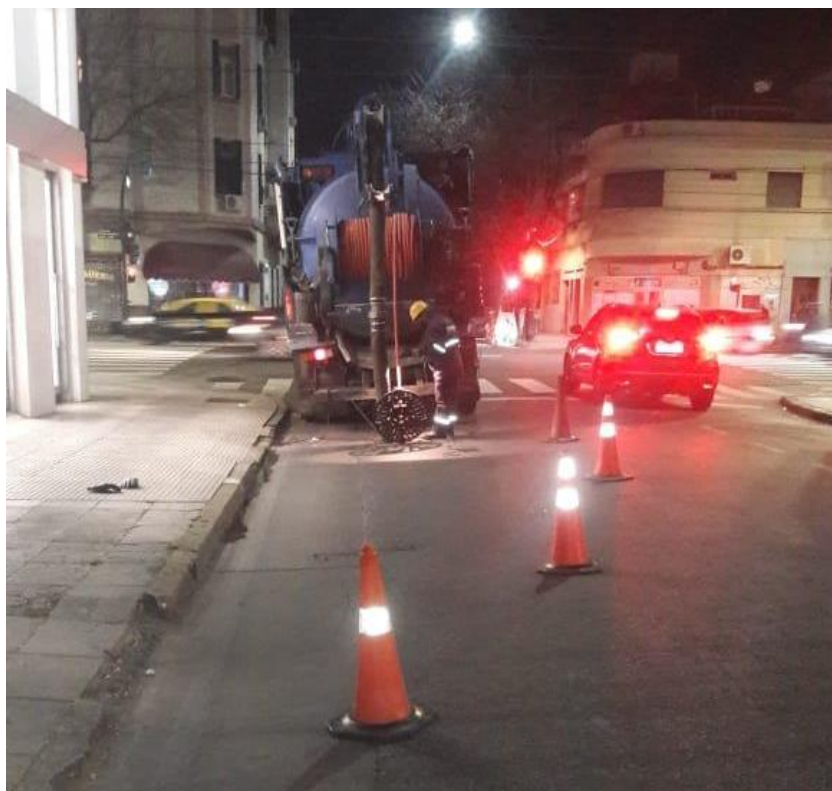
Imagen 15. Delimitación de la zona de trabajo del camión desobstructor (Fuente: Forever Pipe).
