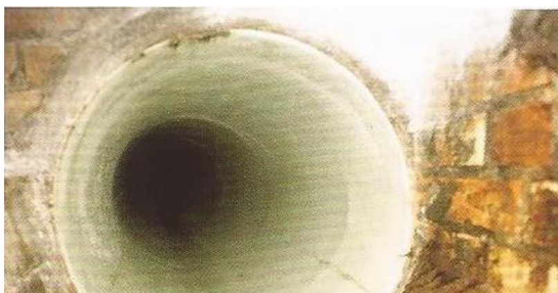
Imagen 22. Cañería polimerizada y sellada en cámara de inspección (Fuente: Memoria técnica de manga de curado UV, Forever Pipe, 2023).
