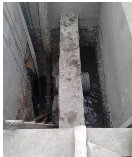
Imagen de pared construida en cámara
