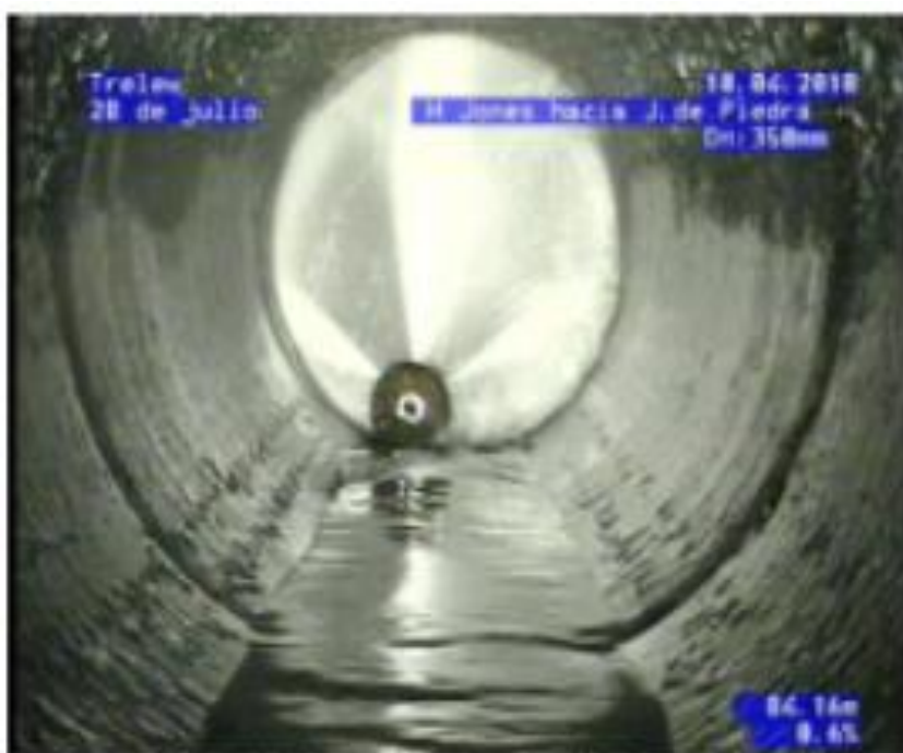
Imagen 16. Tobera trabajando en interior de cañería (Fuente: Forever Pipe,2023).
