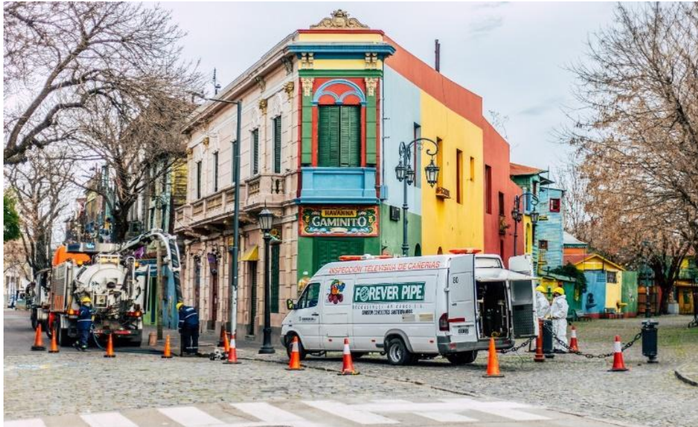
Imagen 11. Demarcación de la zona de trabajo para tele inspección de cañerías (Fuente: Forever Pipe).
