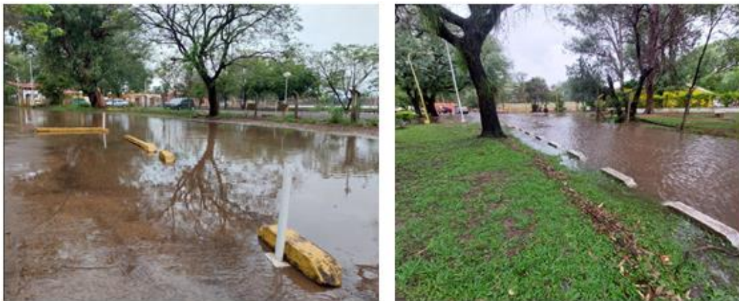
Imagen 36. Respuesta del sistema ante la precipitación del 30 de octubre del 2023 - Colector 1 (Fuente: fotografía propia).
