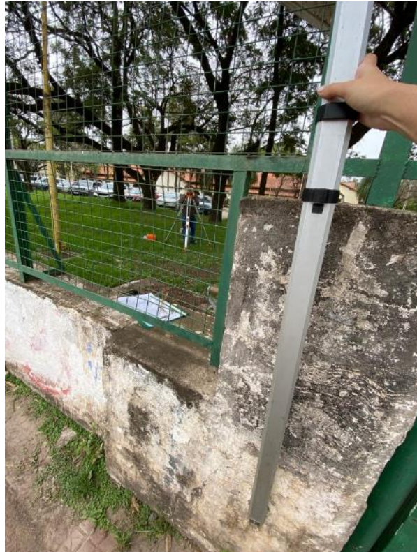
Imagen 26. Nivelación por rodeo a partir de la ménsula APA en muro de la UNNE sobre Av. Castelli (Fuente: Fotografía propia, 2023).
