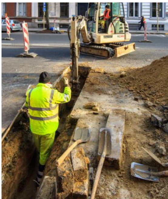
Imagen 8. Excavación y disposición del material excavado en zona urbana (Fuente: ¿Cómo se realiza la excavación de una zanja?, Sevillano Grasa, 2021).
