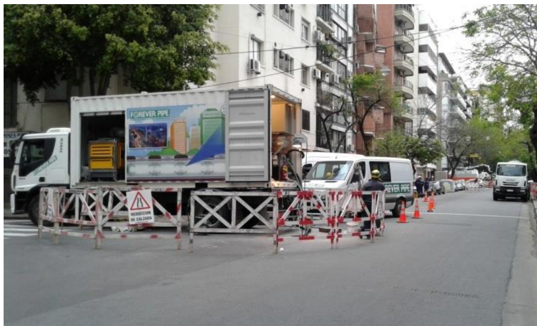
Camión con equipamiento para manga UV durante proceso de curado y rehabilitación.
