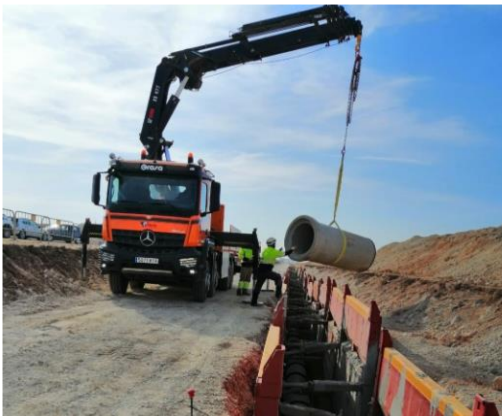
Imagen 7. Equipos para la manipulación de cañerías (Fuente: ¿Cómo se realiza la excavación de una zanja? , Sevillano Grasa, 2021).
