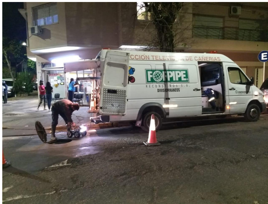
Imagen 12. Inserción del robot para inspección de cañerías (Fuente: Forever Pipe).
