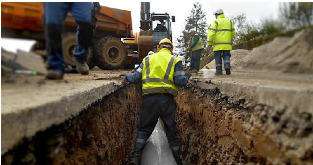
Imagen 6. Libre acceso a las cañerías (Fuente: ¿Cómo se realiza la excavación de una zanja?, Sevillano Grasa, 2021).
