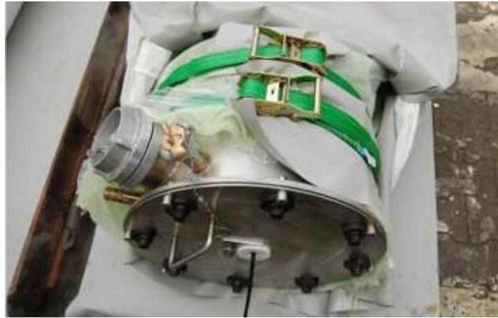
Imagen 20. Sujeción de la manga al empacador (Fuente: Memoria técnica de manga de curado UV, Forever Pipe,2023).
