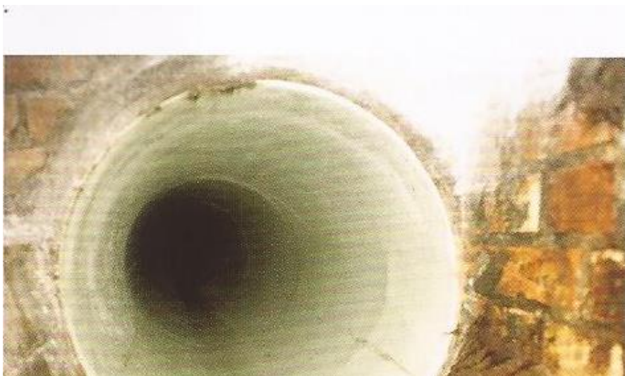
Cañería polimerizada y sellada en cámara de inspección
