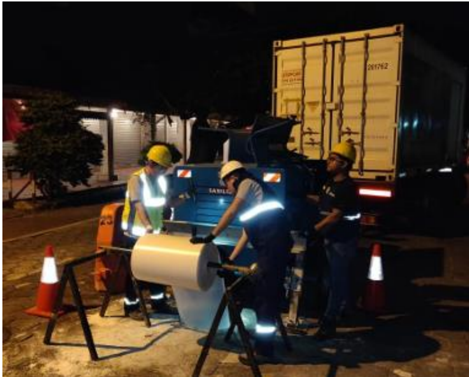
Imagen 19. Inserción del pre liner (Fuente: Forever Pipe, 2023).
