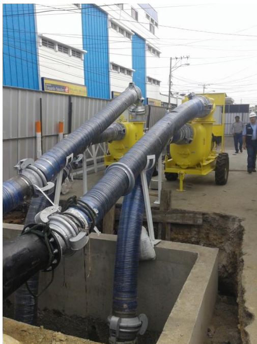
Imágenes de disposición de motobombas en cámaras
