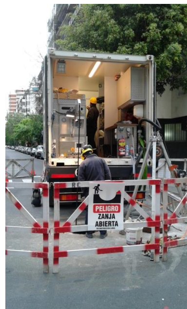
Camión con equipamiento para manga UV durante proceso de curado y rehabilitación.
