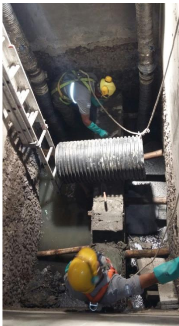
Imagen de proceso constructivo de pared
