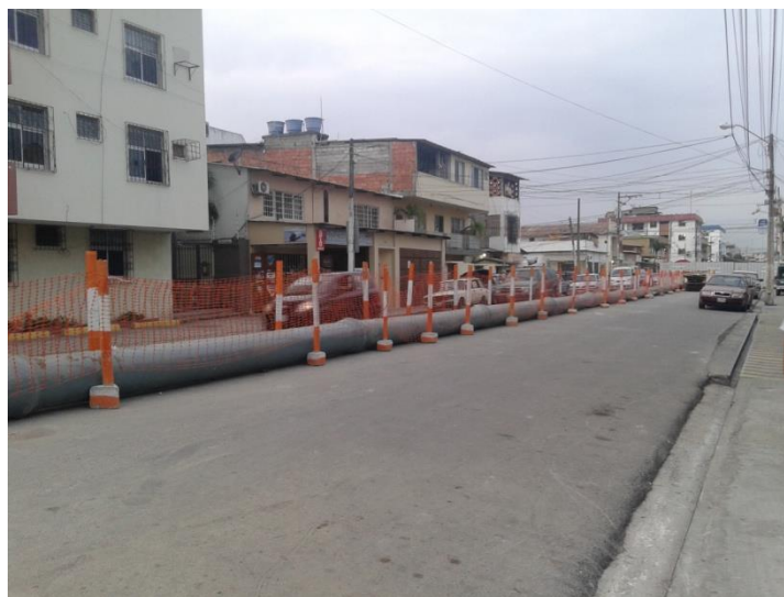
Imágenes de líneas de by pass sobre calzada, con tuberías de PVC y mangas flexibles
