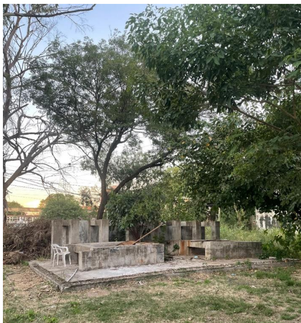
Imagen 40. Zonas impermeabilizadas por estructuras de hormigón que están en desuso (Fuente: fotografía propia, 2024).
