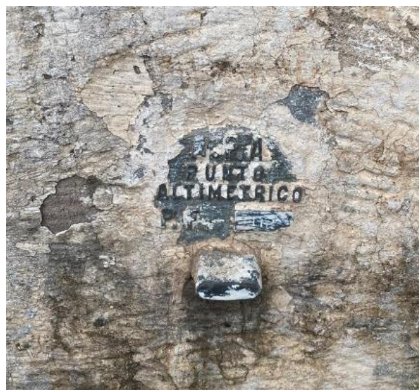
Imagen 25. Ménsula APA en muro de la UNNE sobre Av. Castelli (Fuente: Fotografía propia, 2023).
