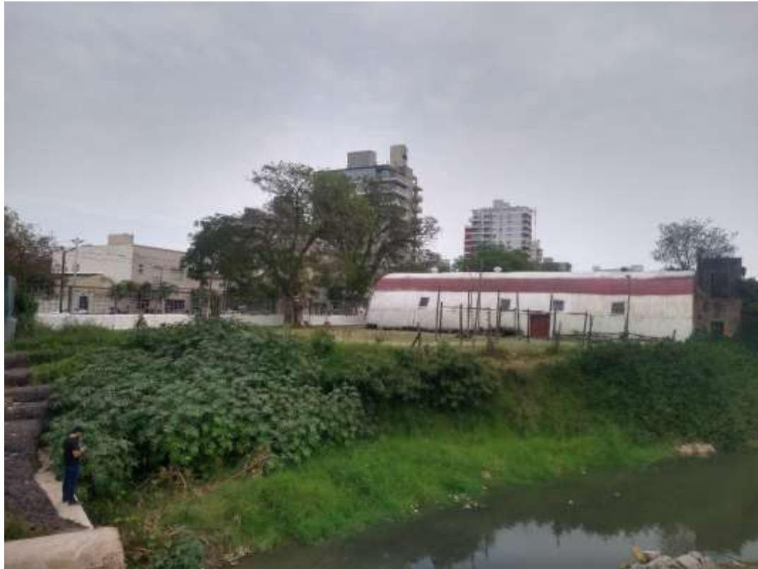
Imagen 1.4. Vista de la extensión del talud oeste. (Fuente: imagen propia)
