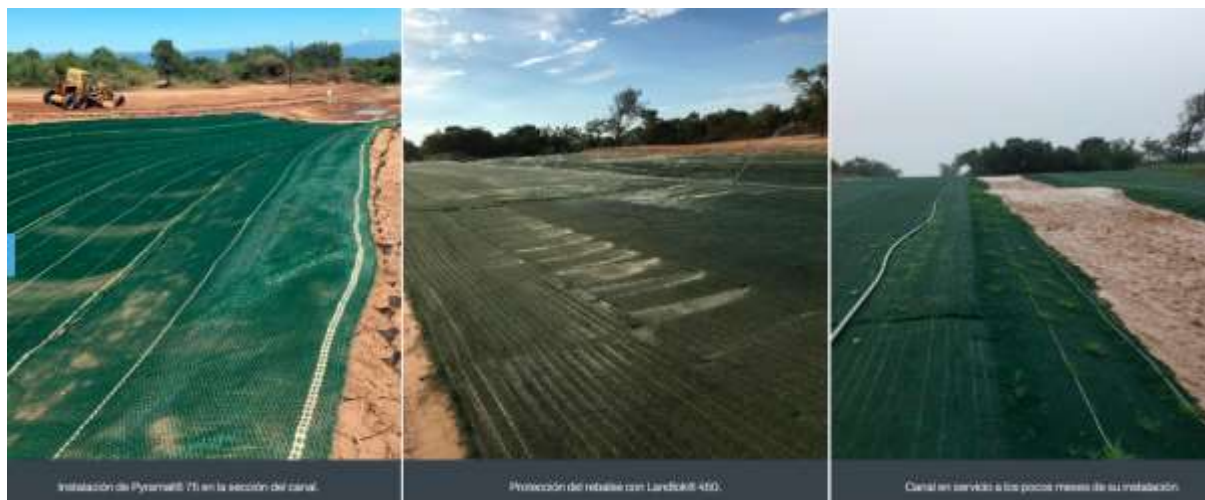
Imagen 5.8 Fotografías in-situ de la geomanta (Fuente: página web de Coripa)
