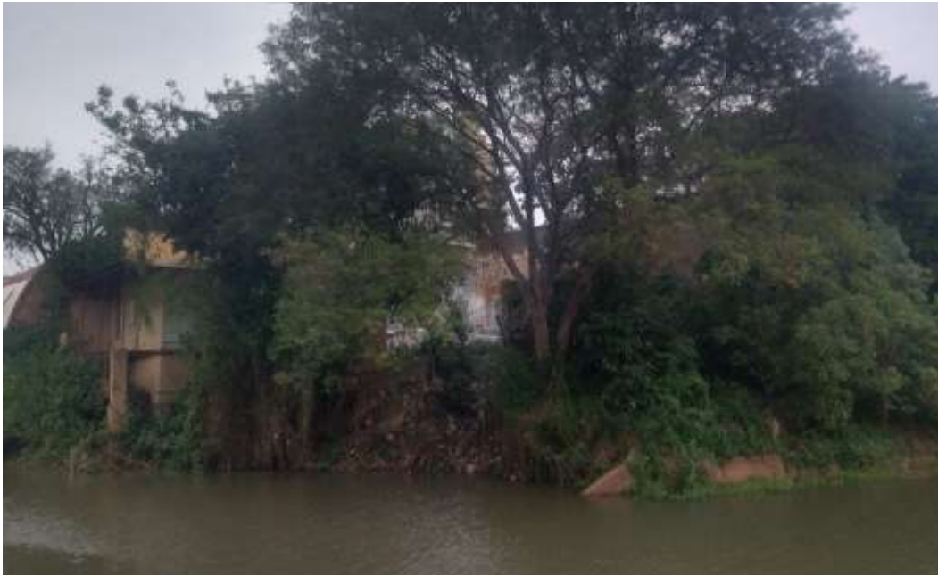
Imagen 5.2 Efectos de erosión en el arroyo Poncho Verde (Fuente: propia)
