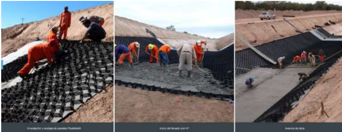
Imagen 5.6 Proceso de colocación y llenado de las geoceldas con hormigón (Fuente: página web de Coripa)
