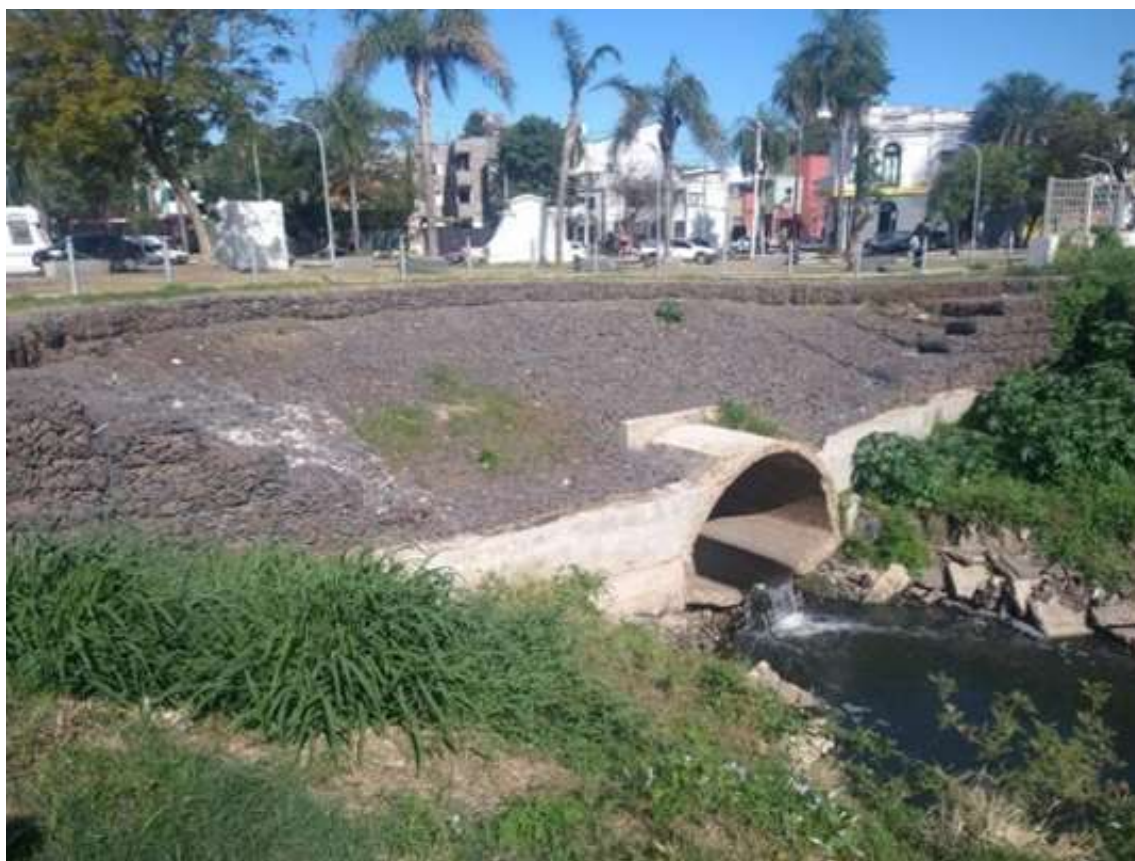
Imagen 1.4 Alcantarilla existente (Fuente: imagen propia).
