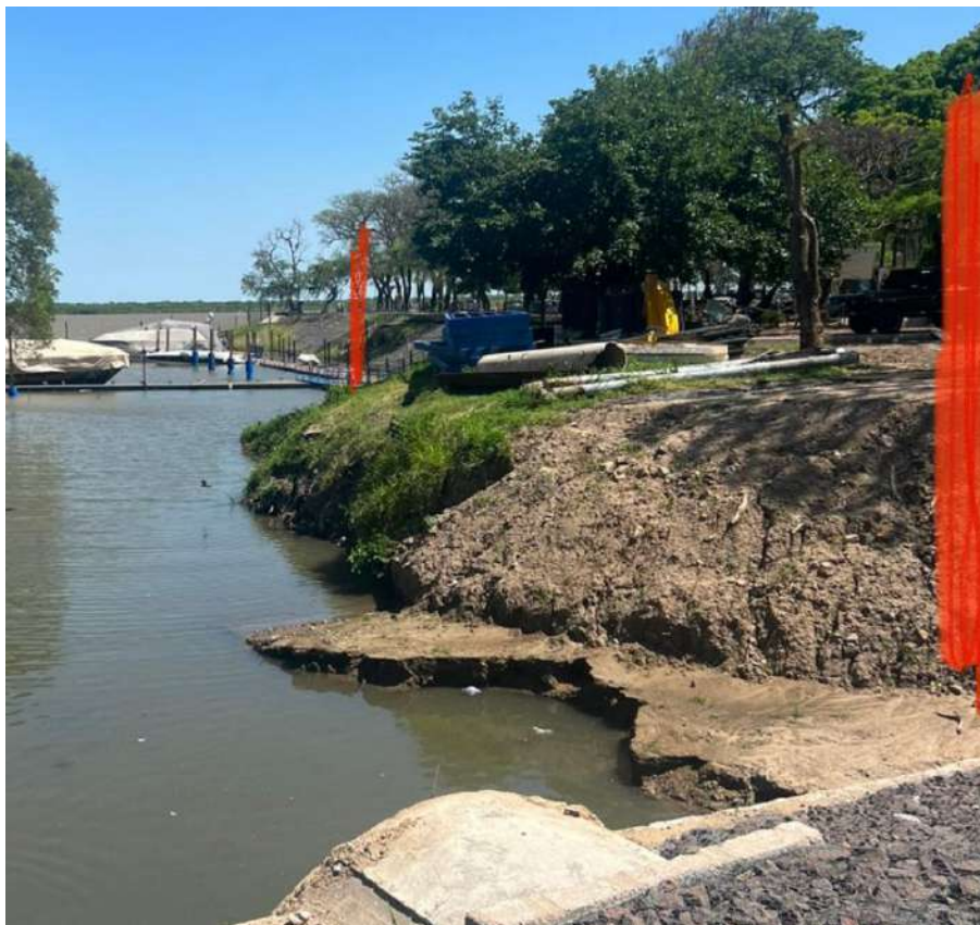
Fig. 3. Taludes a intervenir.
