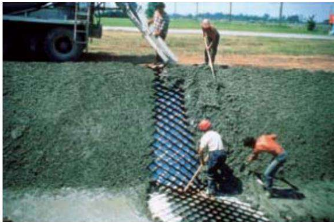
Fig. 9. Relleno de celdas con hormigón
