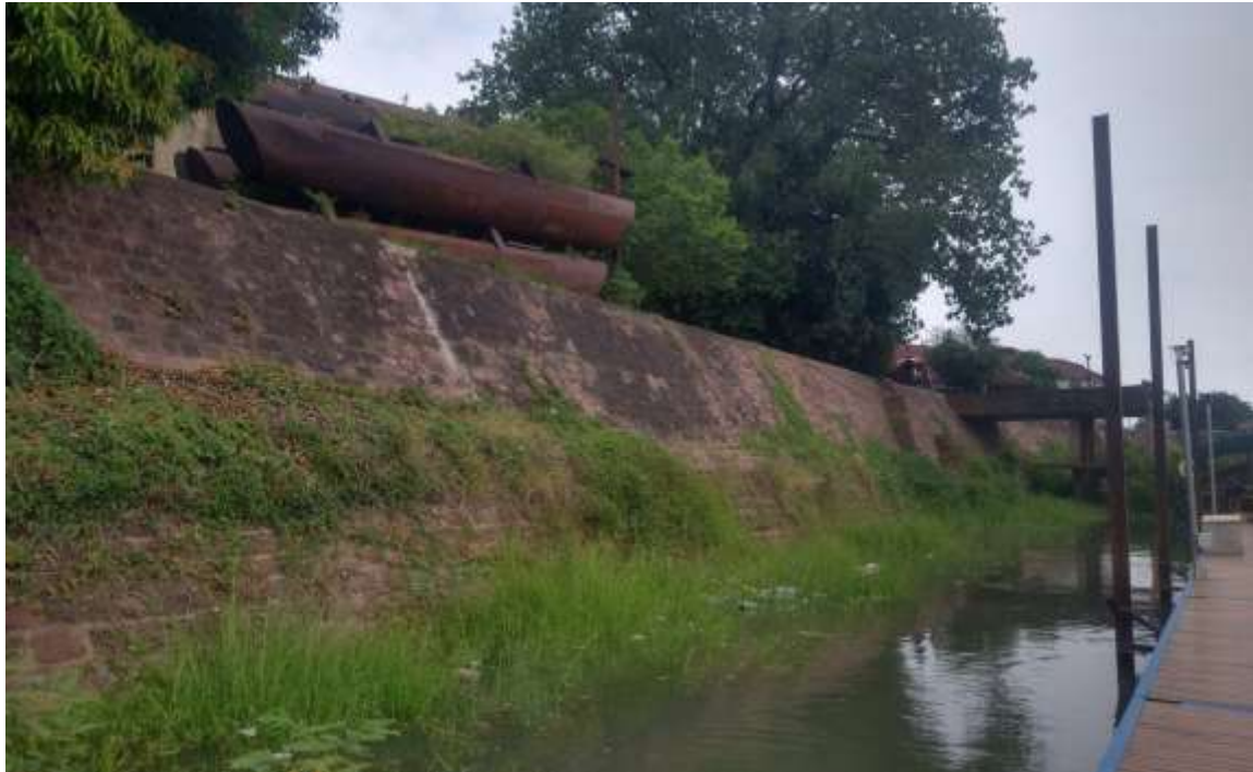
Imagen 2.4 Fotografía del muro de contención de paramento vertical del talud oeste. (Fuente: Propia)
