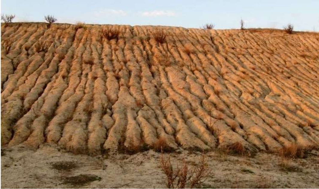
Imagen 5.1 Efectos de erosión en un talud de arena (Fuente: https://www.biodiversidadvirtual.org/ )
