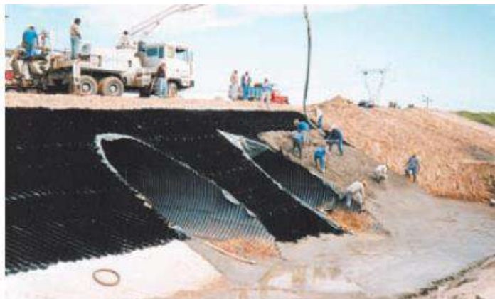
Fig. 19. Instalación del resto de los anclajes.
