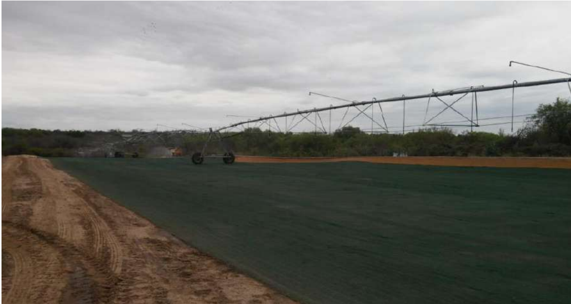
Fig. 21. Geomantas utilizadas para control de erosión en campos
