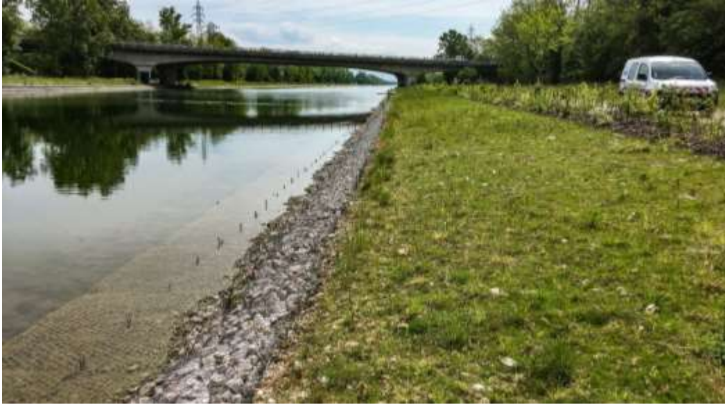
Imagen 5.9 Fotografías in-situ de un talud revestido con gaviones (Fuente: página web de Maccaferri)
