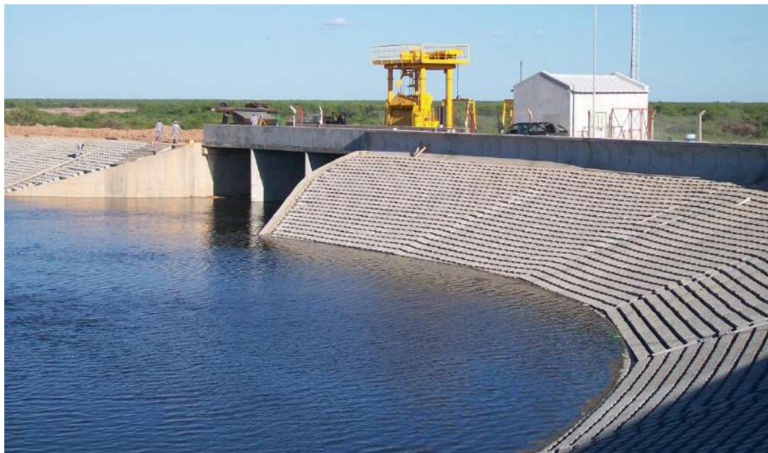
Fig. 7. Revestimiento Betonflex terminado
