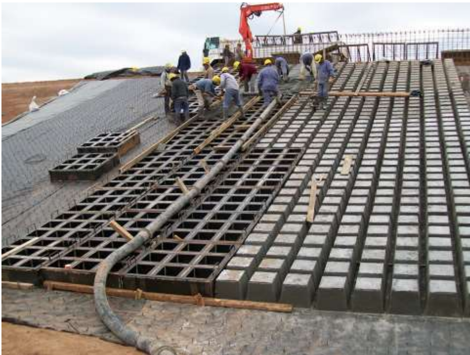
Imagen 5.4 Proceso constructivo sistema Betonflex (Fuente: página web de Coripa)
