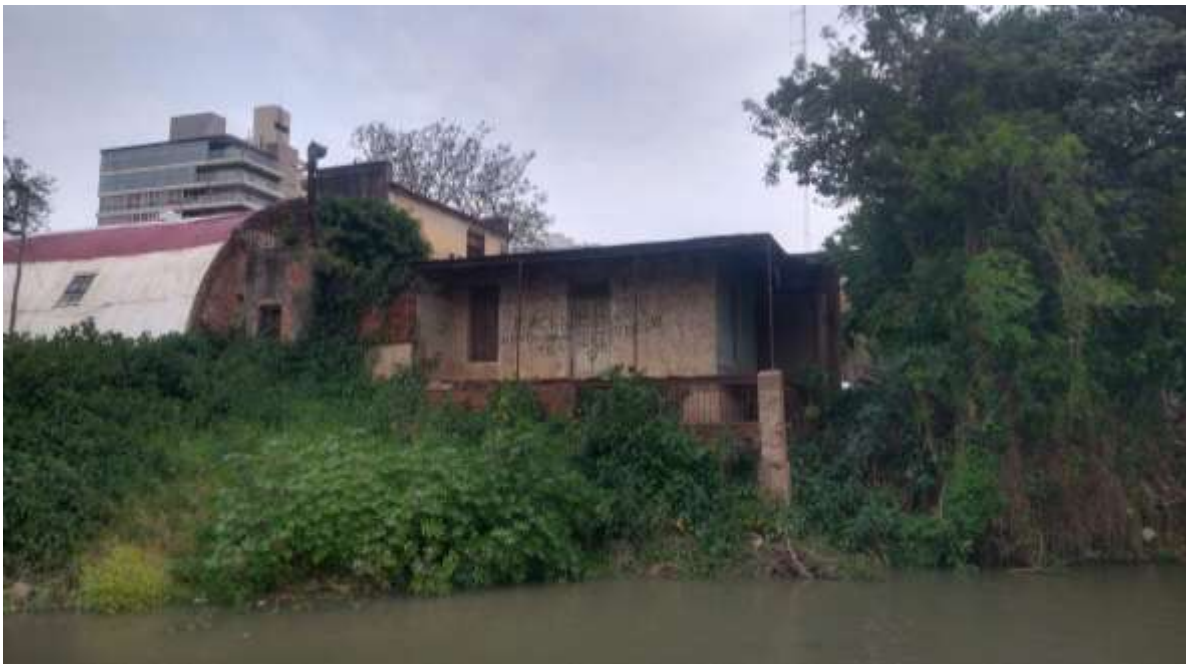
Imagen 2.5 Fotografía de las construcciones que sufrieron los efectos de la erosión. (Fuente: Propia)
