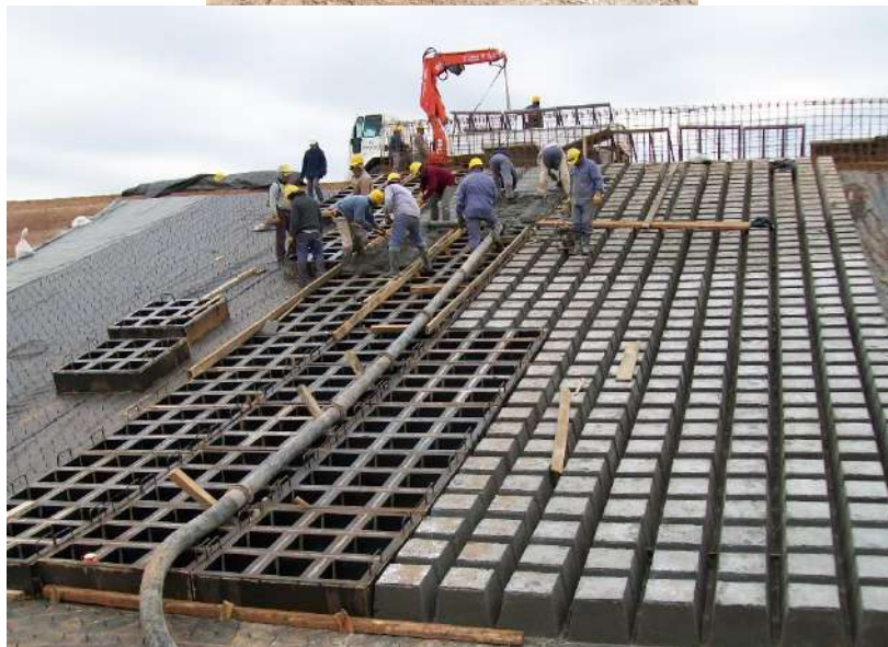
Fig. 6. Despliegue de geotextil, colocación de moldes y hormigonado de bloques
