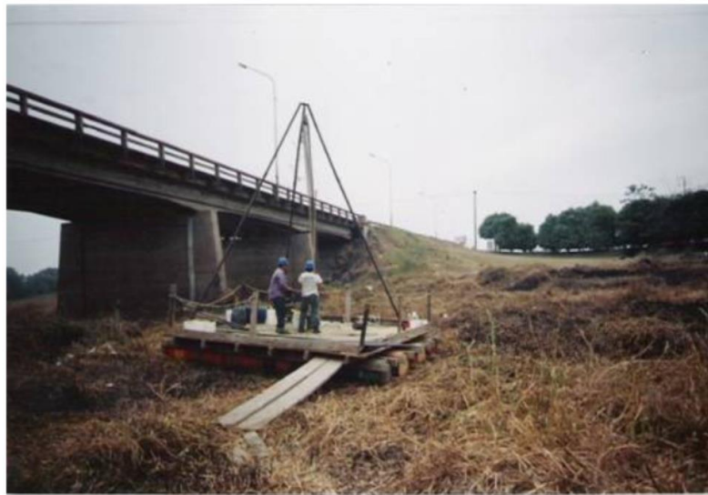
Fotografía N°10: Ejecución sondeo N°10.
