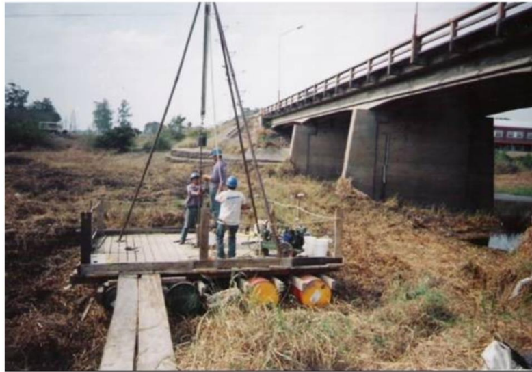
Fotografía N°9: Ejecución sondeo N°9.
