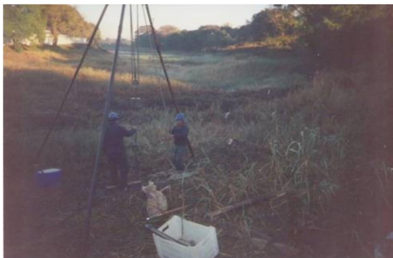
Fotografía N°5: Ejecución sondeo N°5.
