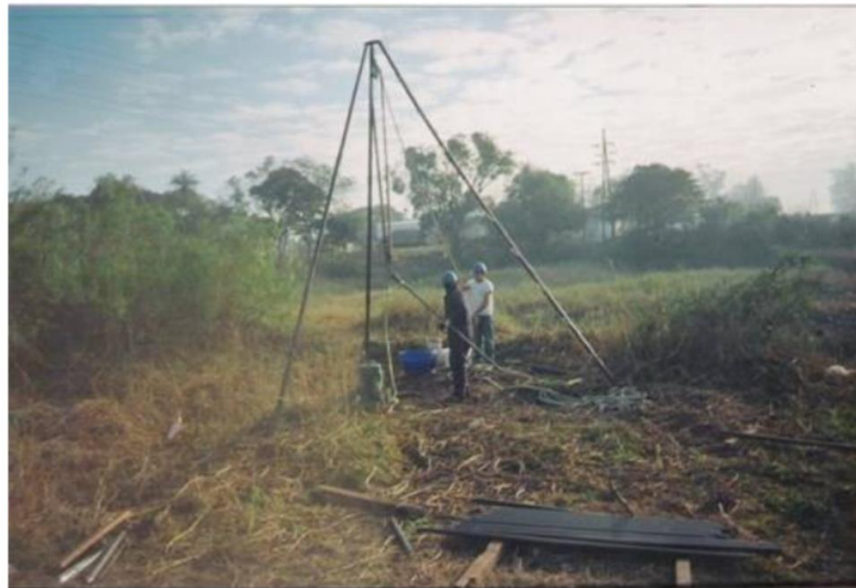
Fotografía N°3: Ejecución sondeo N°3.
