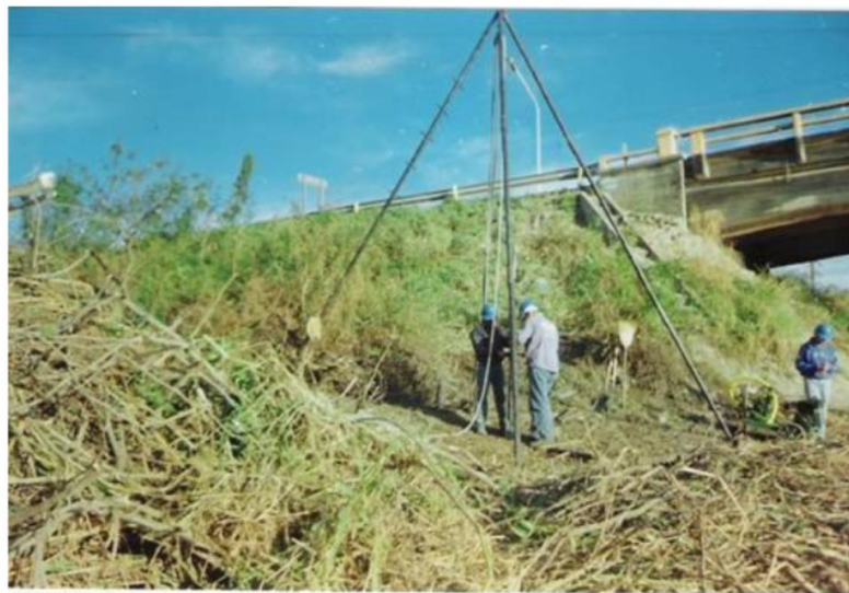
Fotografía N°4: Ejecución sondeo N°4.
