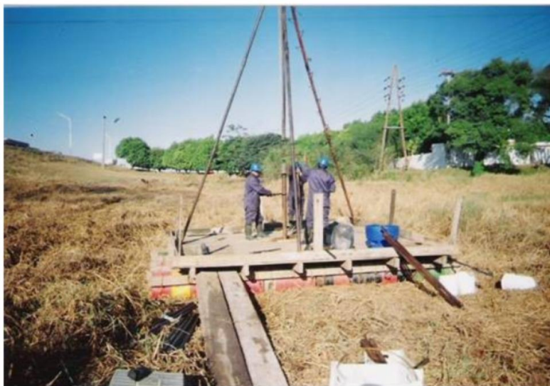
Fotografía N°11: Ejecución sondeo N°11.
