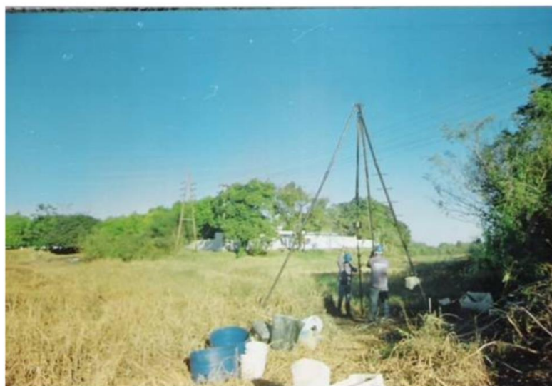
Fotografía N°6: Ejecución sondeo N°6.
