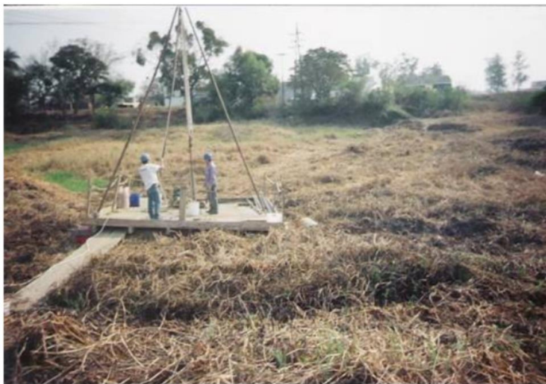
Fotografía N°12: Ejecución sondeo N°12.
