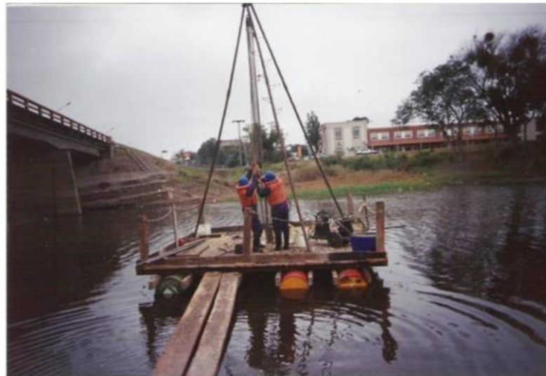
Fotografía N°8: Ejecución sondeo N°8.
