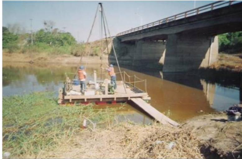
Fotografía N°7: Ejecución sondeo N°7.
