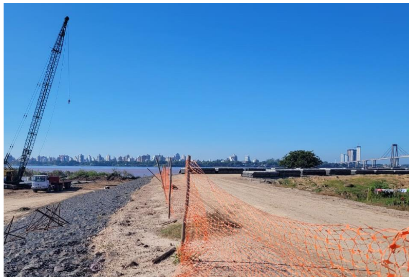
Figura 1.13. Coronamiento de terraplén y recubrimiento con colchonetas de gaviones (abril 2023). Fuente: Elaboración propia
