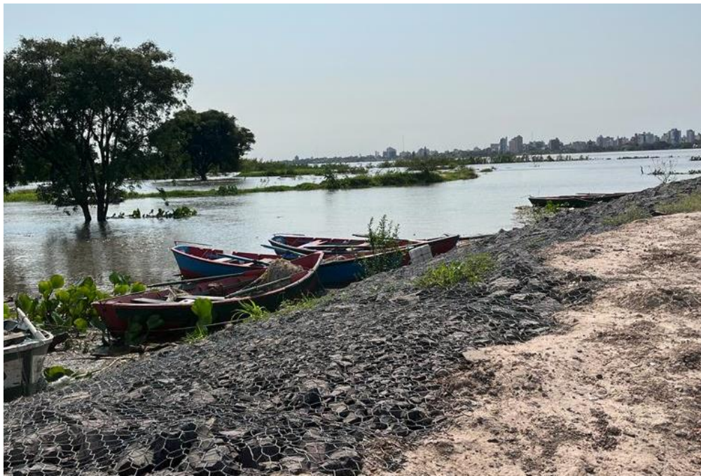
Figura 1.32. Fotografía tomada desde el coronamiento del terraplén de defensa contra la erosión.
