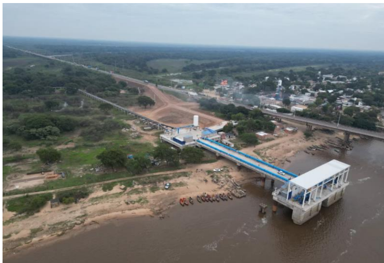
Figura 1.8. Toma de agua para el segundo acueducto. Fuente: SAMEEP
