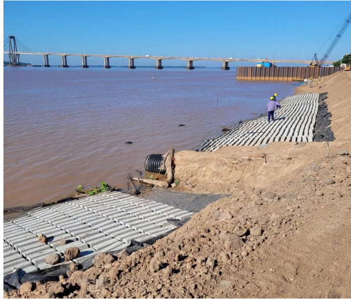
Figura 1.12. Descarga de desagües pluviales al río Paraná. Fuente: Elaboración propia
