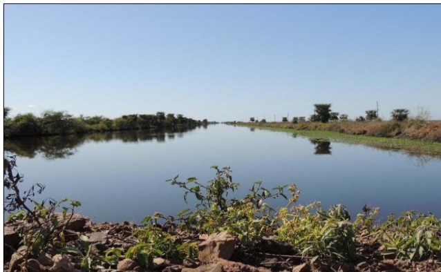
Imagen N°75: Canal Principal. Fuente: Propia.
