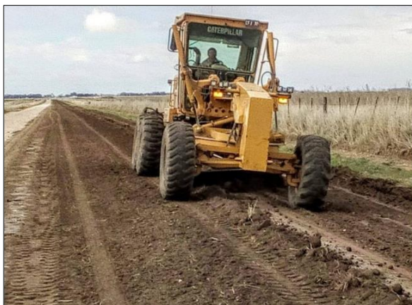
Imagen N°73: Mantenimiento de camino de chacra con motoniveladora. Fuente: Propia
