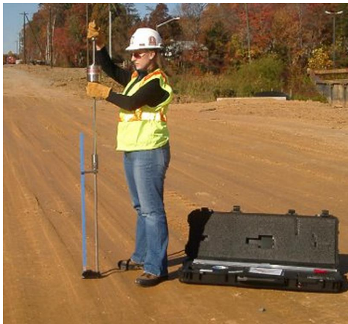
Figura 3.7. Ensayo in situ de cono dinámico de penetración (fuente: Cátedra de Vías de comunicación I).
