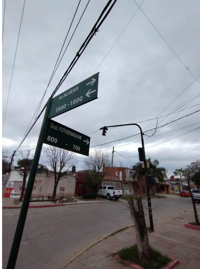
Figura 6.12. Semáforo en sentido opuesto a la circulación (fuente: Elaboración propia).
