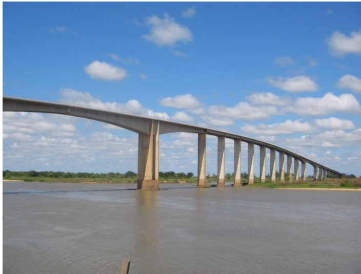
Figura II.42 Fotografía puente Concepción Pto. Militar (Fuente: Diario Concepción).
