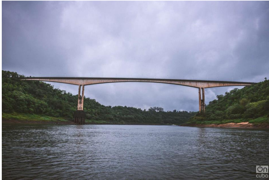
Figura II.38 Fig. II.38. Puente “Puente Internacional Tancredo Neves” (Fuente: ON Cuba).
