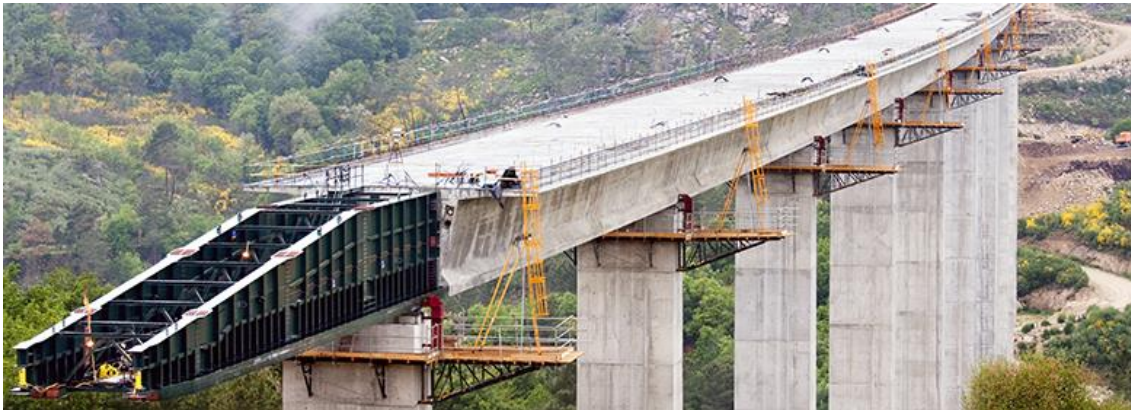
Figura II.27 Puente desarrollado a partir del método de lanzamiento incremental (Fuente: [17]).
