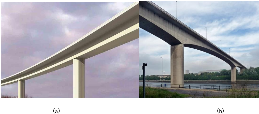
Figura II.12 a) Puente de altura se sección constante Tipo I. b) Puente de altura se sección e inercia variable Tipo III (Fuente: [14] Manterola J. Puentes tomo I).
