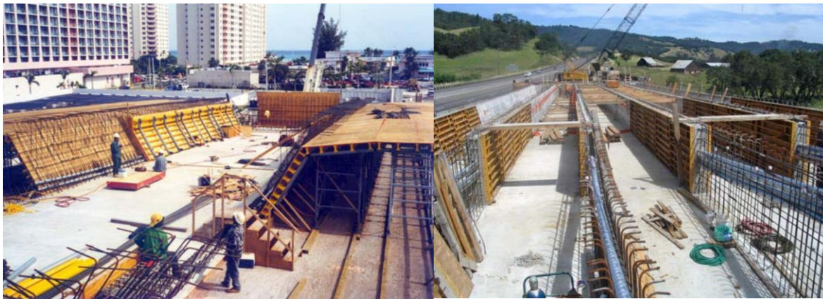
Figura II.23 a) Encofrado de viga cajón monocelular. b) Encofrado y hormigonado en etapas de viga cajón de varias células (Fuente: [12]).
