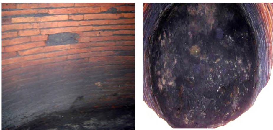
Fotos 56 y 57. Foto del nivel I, se ve en detalle los ladrillos faltantes y foto del nivel II, en donde empiezan a aparecer las primeras losetas. (Fotos: Lic. Belén Aguirre)
