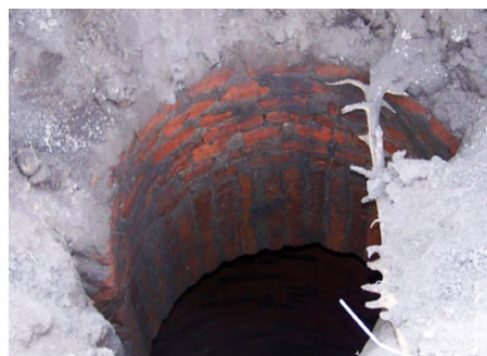
Foto 29. Foto donde se observa el detalle de la boca del pozo con el calce en ladrillos en buen estado de conservación. (Fuente foto: Lic. B. Aguirre)
