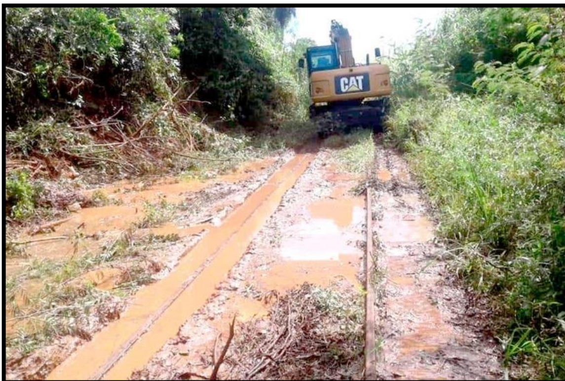
Imagen 45. Limpieza de vía.
