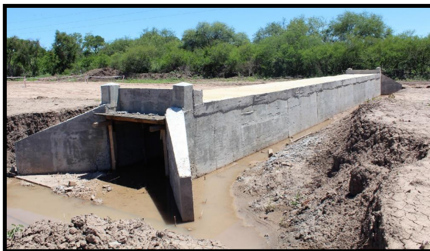
Imagen 53. Alcantarillas rectangular finalizada.
