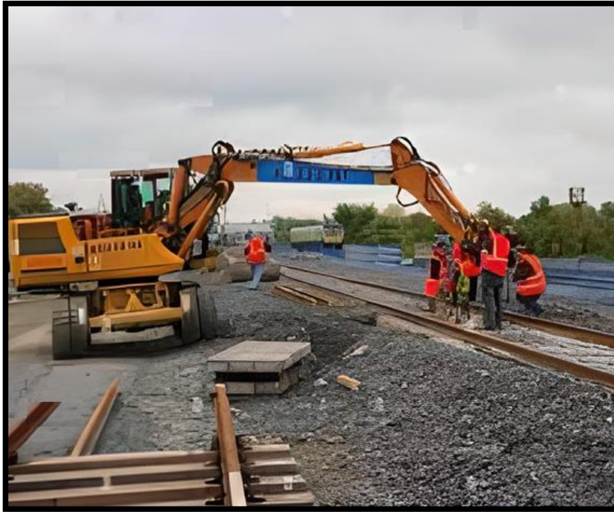
Imagen 57. Colocación de Riele.
