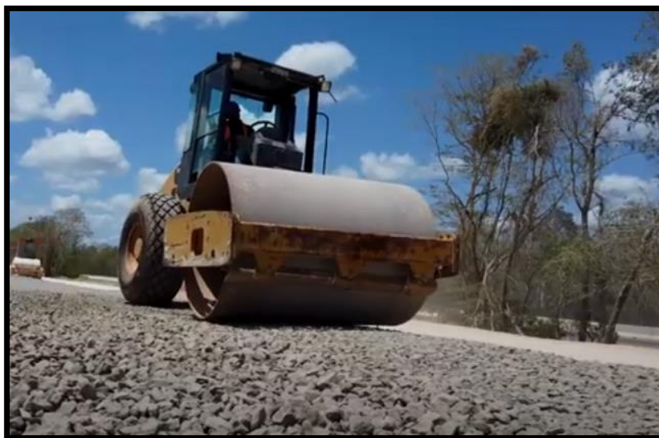
Imagen 55. Compactación de capa de balasto.
