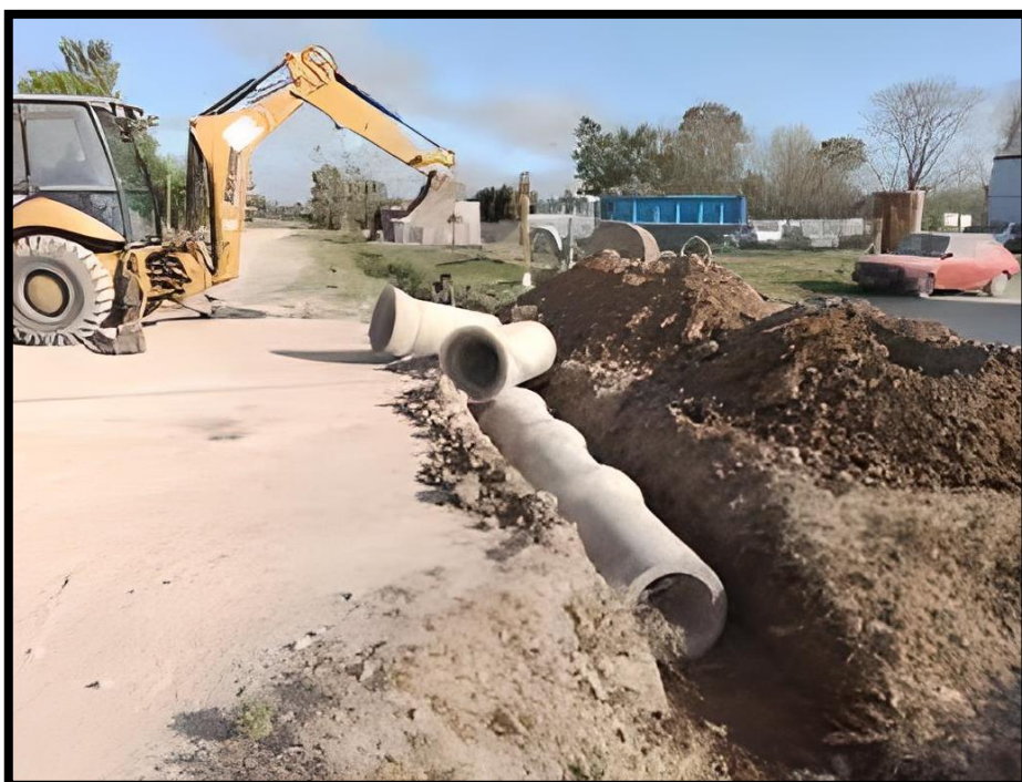
Imagen 50: Colocación de tubos de hormigón para alcantarillas.
