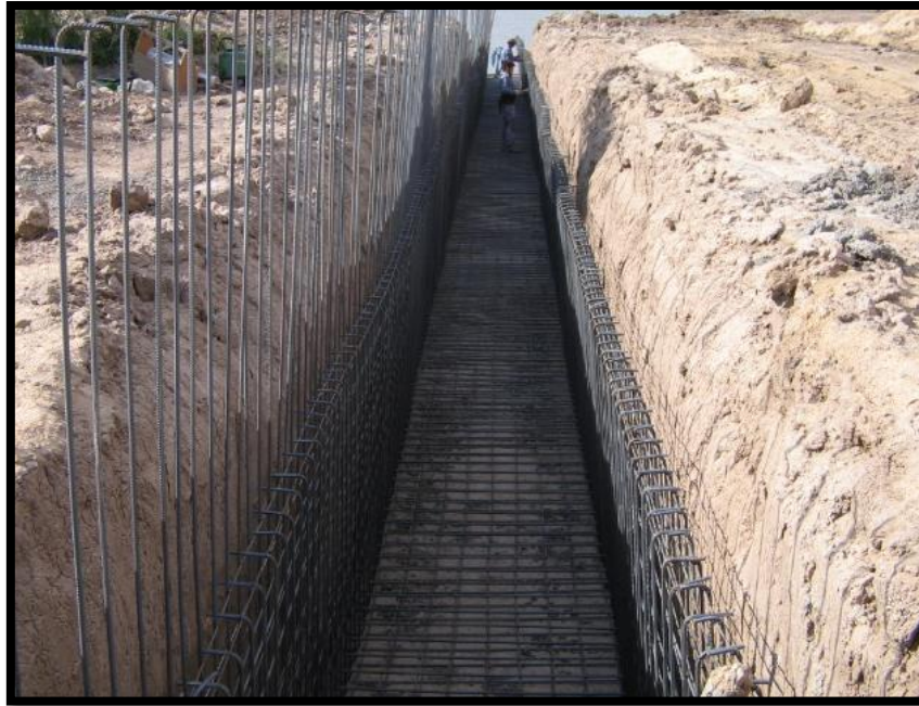
Imagen 51. Colocación de armaduras para alcantarillas rectangulares.
