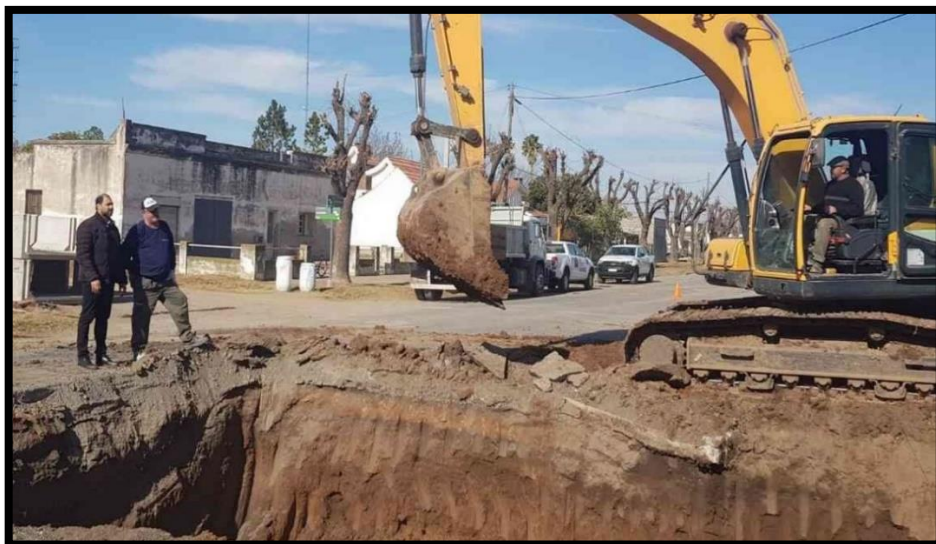
Imagen 49. Excavadora realizando zanja por dónde va la alcantarilla.
