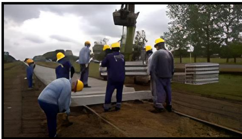
Imagen 56. Colocación de durmientes.
