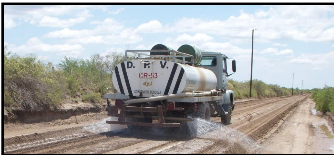
Imagen 48. Camión regador sobre terraplén.
