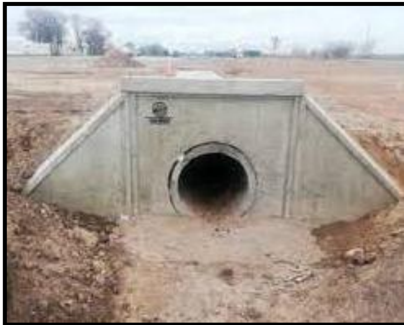
Imagen 52. Alcantarillas de tubos circulares finalizada.
