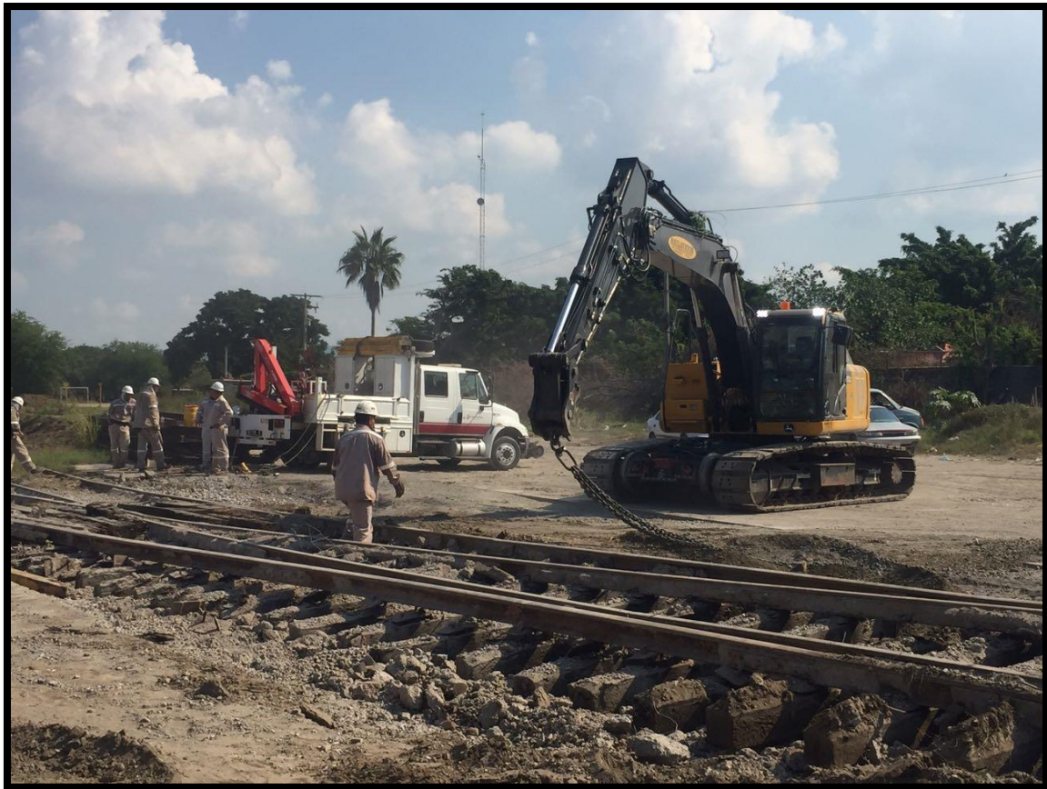
Imagen 46. Retiro de rieles, juntas y eclisas.
