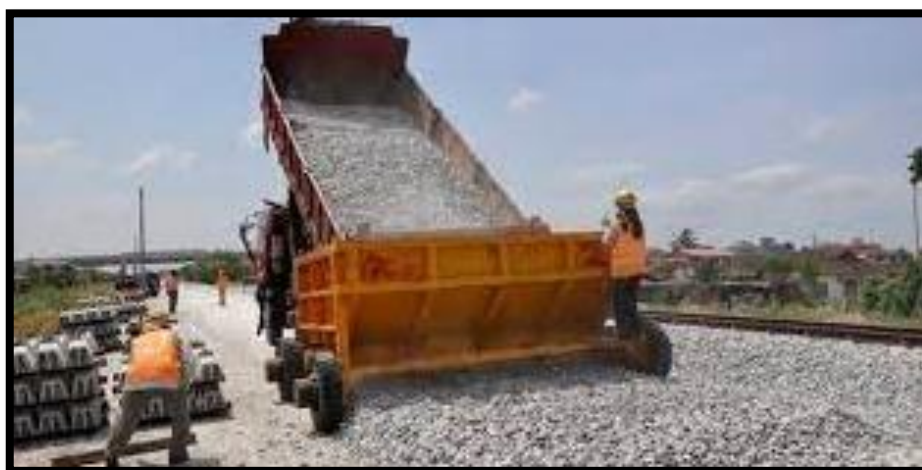
Imagen 54. Descarga de balasto.
