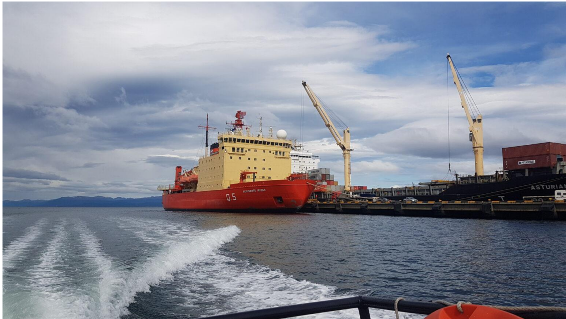
Figura 24 – vista operatoria con rompehielos “Almirante Irizar” y vista de defensas lado Este sector 3 del Puerto de Ushuaia.
