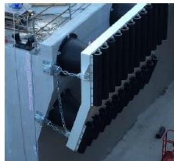
Figura 40 – vista de la deformación de la defensa tipo TCN y armadura con escudo horizontal.
