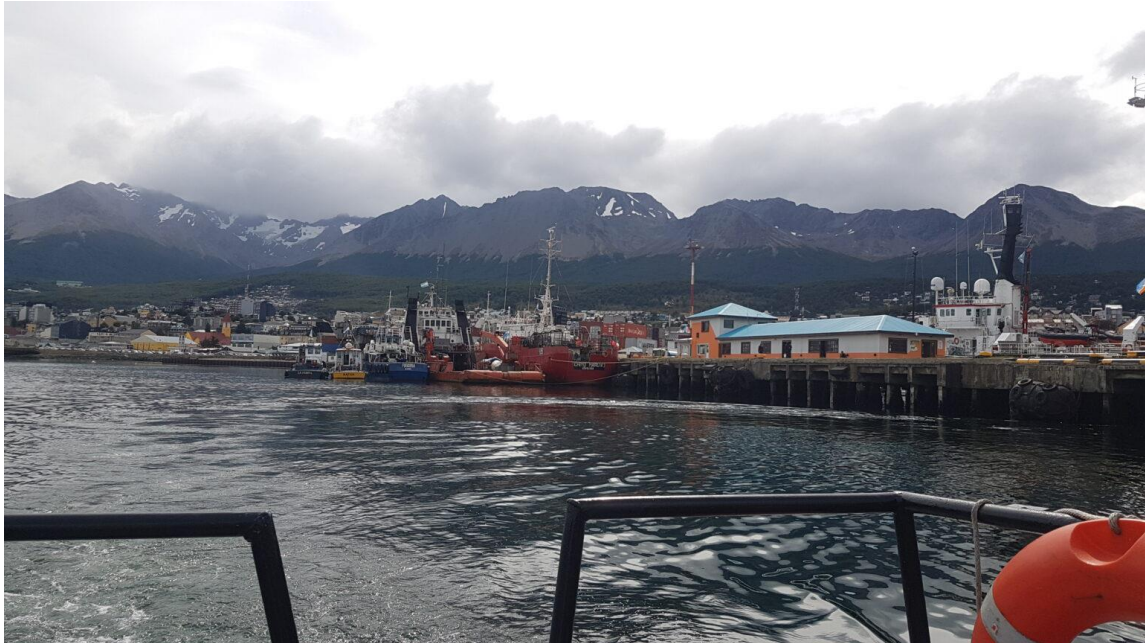
Figura 22 – vista lateral sector de atraque oeste zona 1 del Puerto de Ushuaia.
