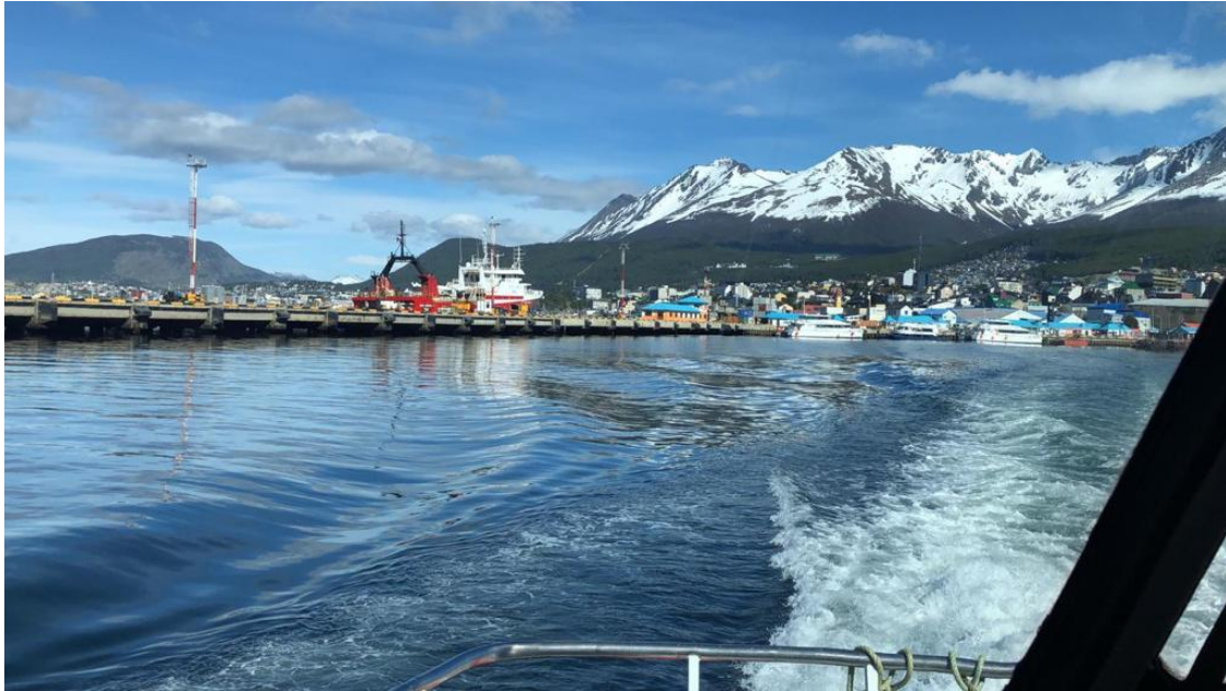
Figura 30 – vista defensas elásticas en lado Este del Puerto de Ushuaia.
