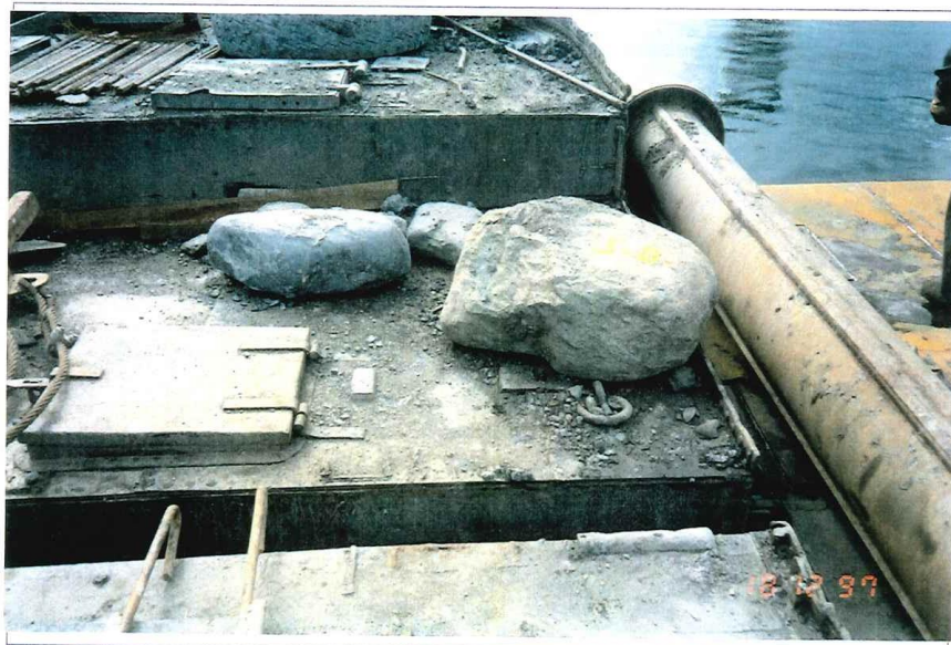
FOTO N° 2 : BOCHONES DE ROCA EXTRAIDOS DURANTE LA EXCAVACION DE PILOTES - DIAMETRO CERCANO A LAS 40 PULGADAS.
