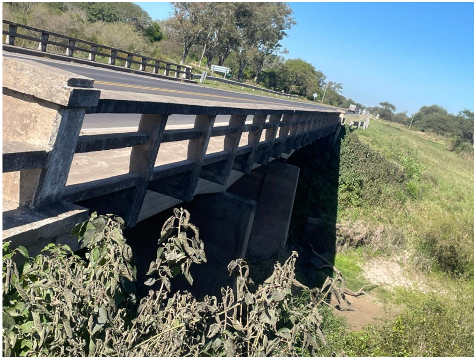
FIGURA I.7: Puente río Tragadero en Ruta Nacional N°11 actualmente.
