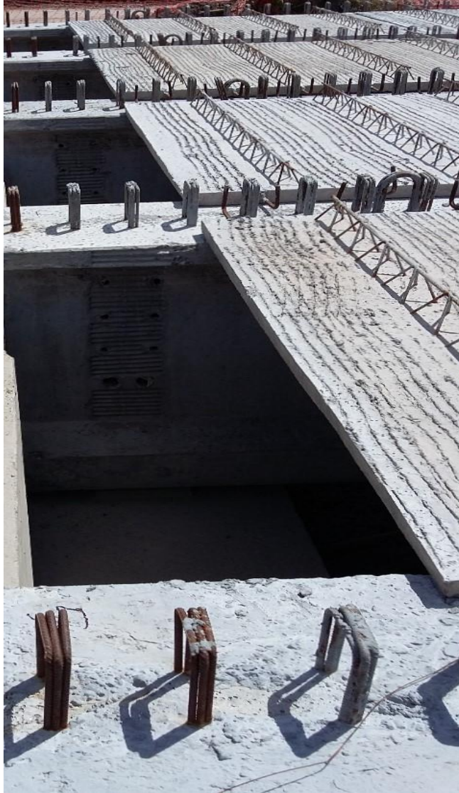
FOTOGRAFIA V.9: Colocación de prelosa. - FUENTE: Catedra Hormigón Armado II.
