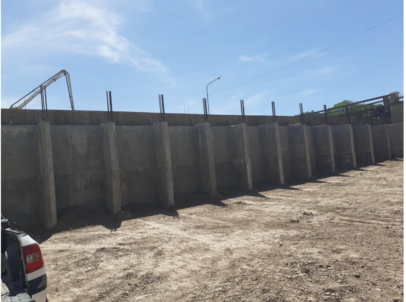
FOTOGRAFIA V.2: Armado de estribos. - FUENTE: Catedra Hormigón Armado II.
