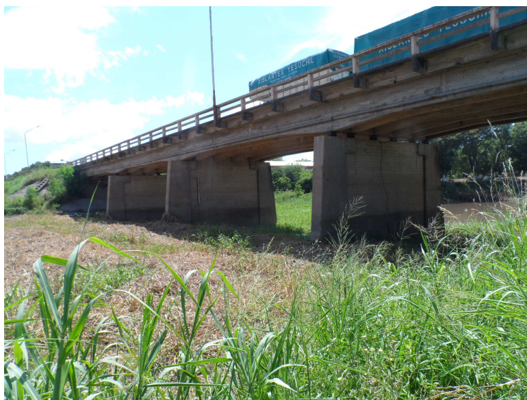
Puente existente sobre el Río Negro
