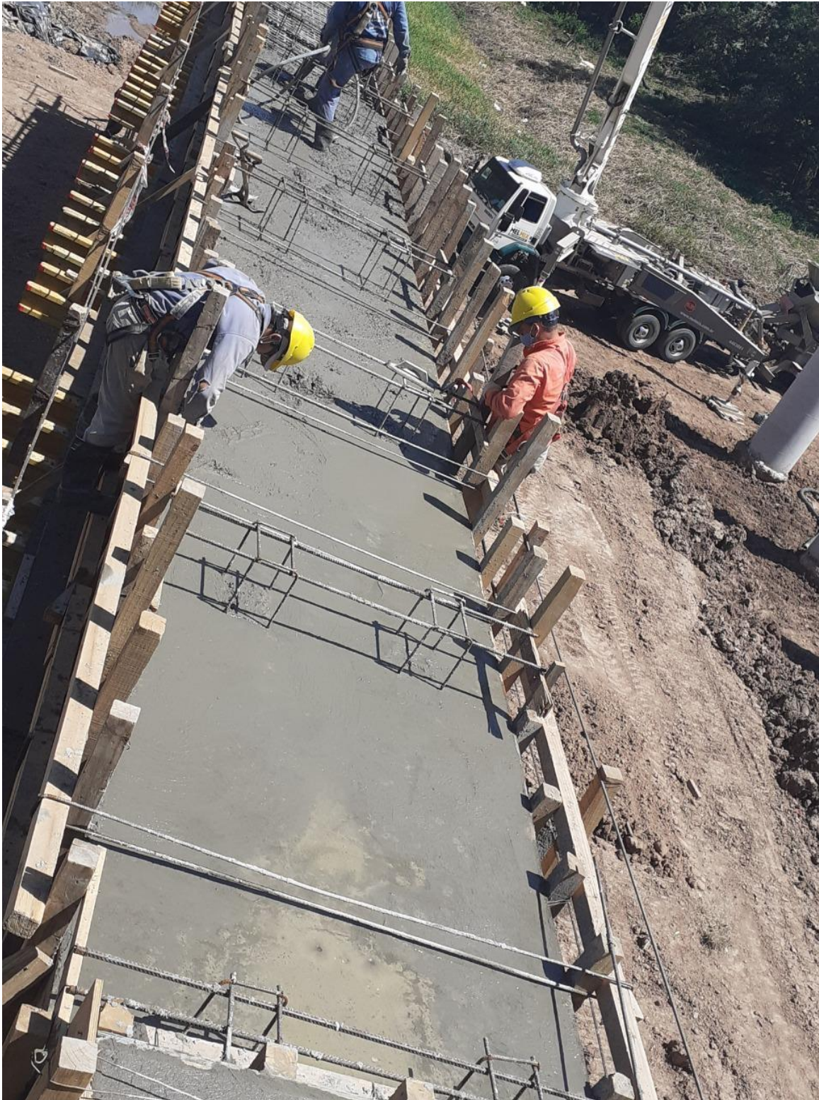
FOTOGRAFIA V.4: Armado de cabezal de pilas intermedias. - FUENTE: Catedra Hormigón Armado II.
