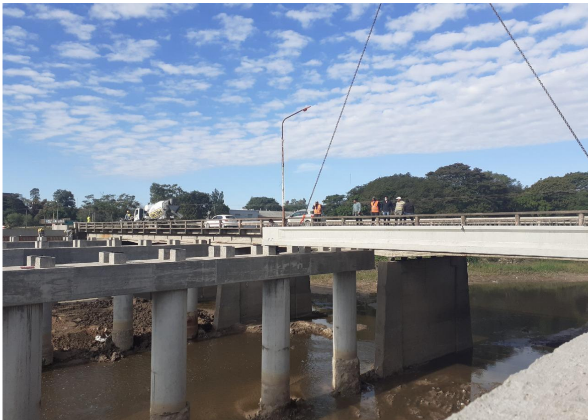
FOTOGRAFIA V.6: Colocación de vigas principales. - FUENTE: Catedra Hormigón Armado II.
