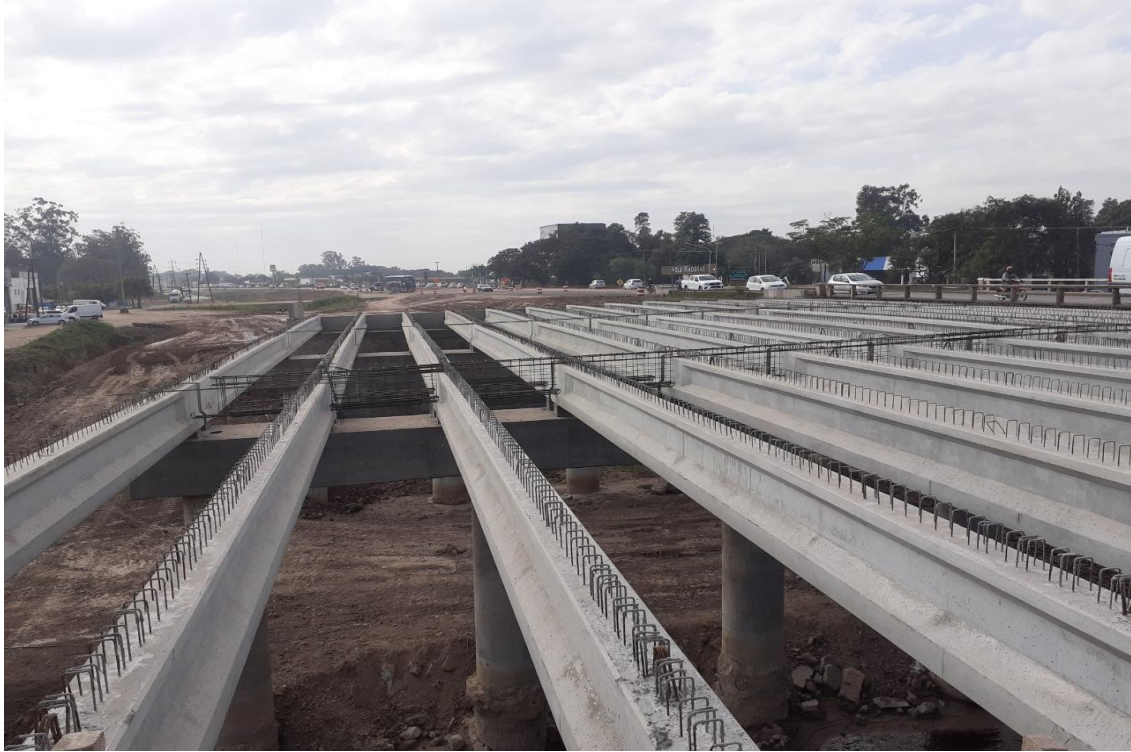
FOTOGRAFIA V.10: Armado de vigas secundarias. - FUENTE: Catedra Hormigón Armado II.
