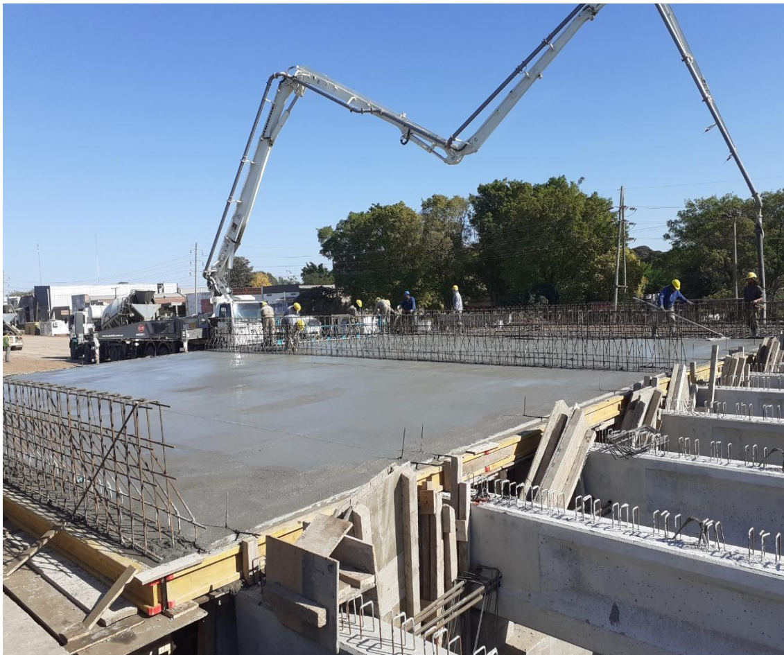
FOTOGRAFIA V.11: Hormigonado de losa de tablero. - FUENTE: Catedra Hormigón Armado II.
