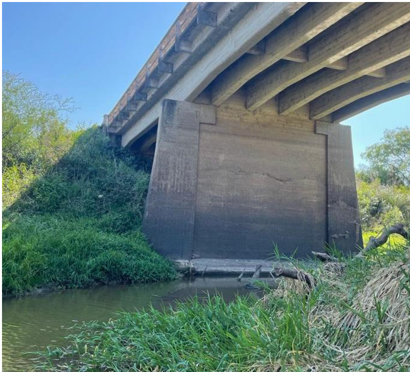
FIG III.6: Marcas de agua en las pilas del puente – FUENTE: Elaboración propia
