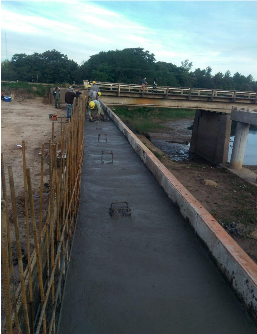
FOTOGRAFIA V.3: Armado de bancada de vigas. - FUENTE: Catedra Hormigón Armado II.
