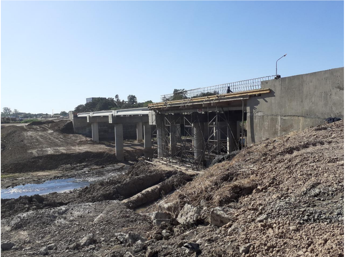
FOTOGRAFIA V.8: Armado de losa de tablero. - FUENTE: Catedra Hormigón Armado II
