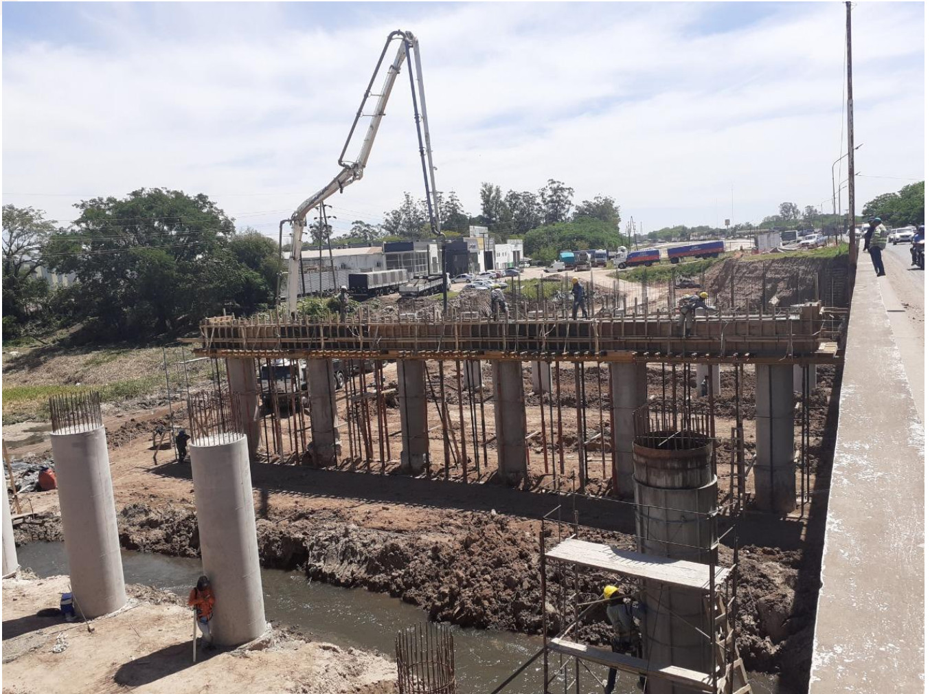
FOTOGRAFIA V.1: Armado de pilas. - FUENTE: Catedra Hormigón Armado II.
