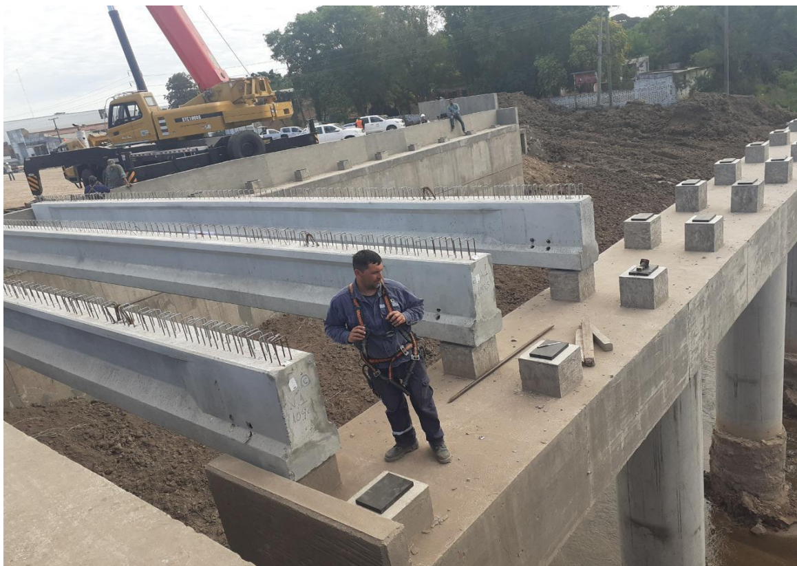
FOTOGRAFIA V.7: Colocación de vigas principales. - FUENTE: Catedra Hormigón Armado II.
