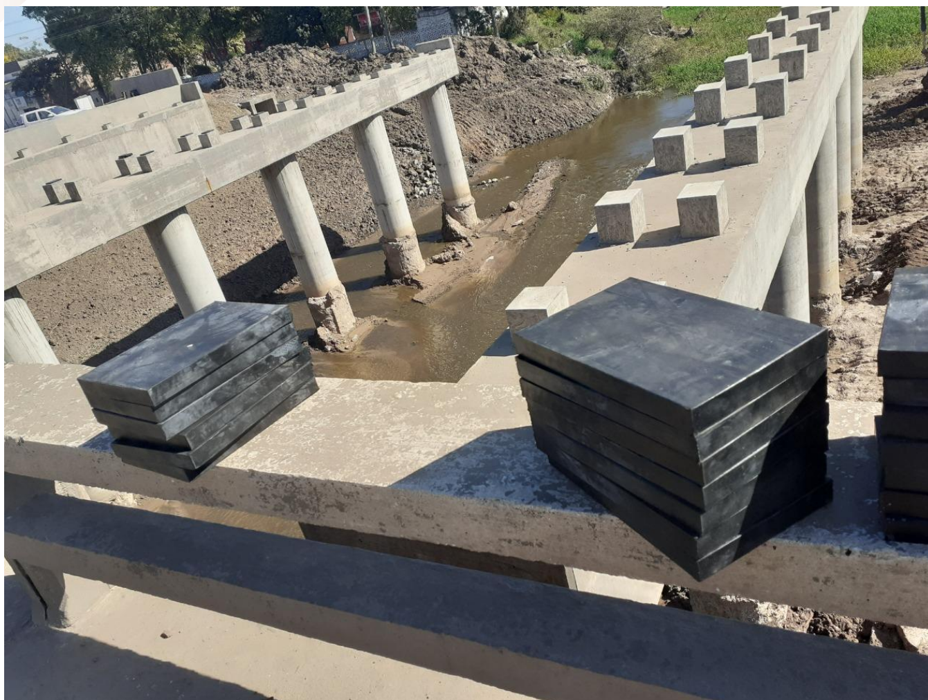
FOTOGRAFIA V.5: Armado de apoyos. - FUENTE: Catedra Hormigón Armado II.
