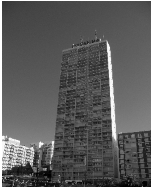
Imagen VI.9. Edificio Demetrio Elíades (Havanna).
