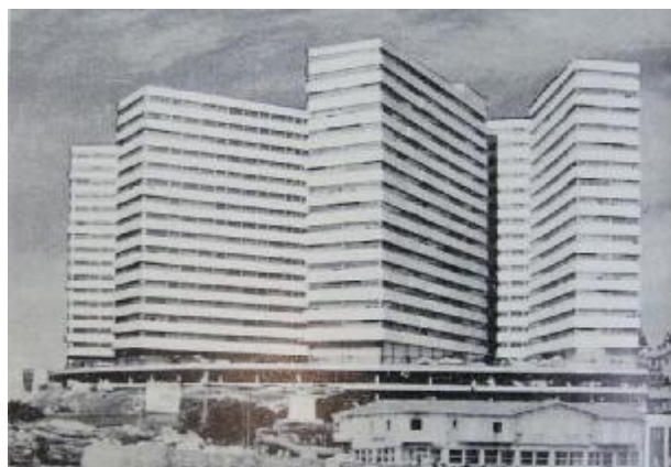
Imagen VI.10. Edificio Cabo Corrientes en estado de terminación (1969)
