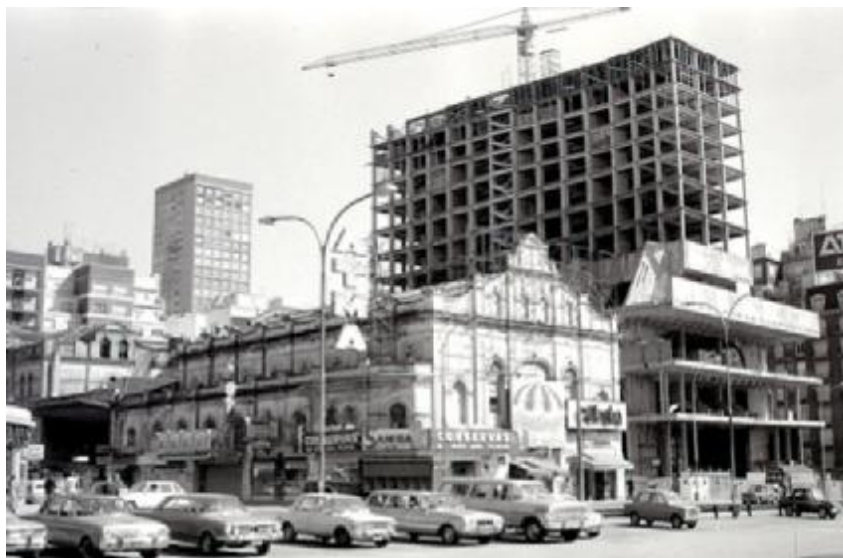
Imagen VI.14. El Bristol Center en construcción en el ángulo izquierdo de la fotografía se visualiza una rugosidad del espacio del período exclusivo-selectivo que fue demolido.
