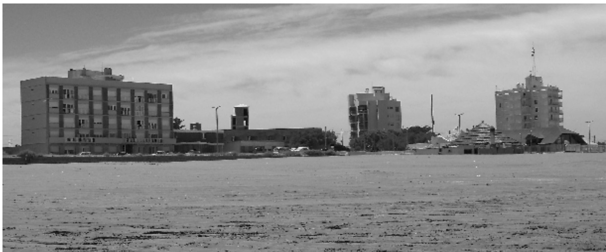
Imagen VI.38. Fachada marítima de Claromecó. Los edificios dispersos que se visualizan fueron construidos a fines de la década de 1970.
