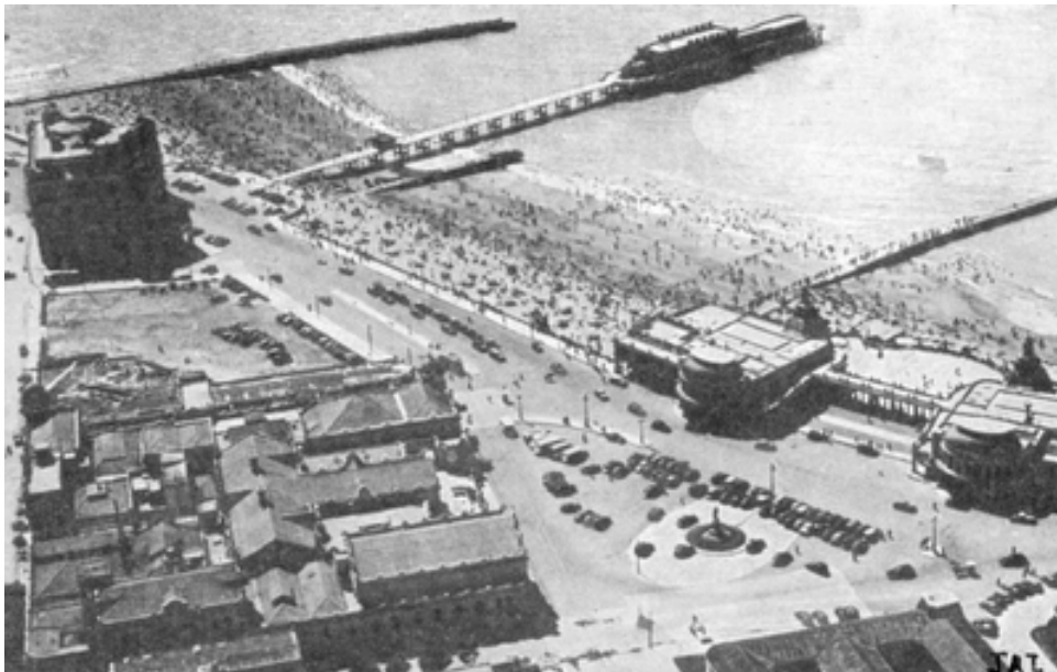
Imagen VI.17. Espigones para defensa costera construidos en 1927.
