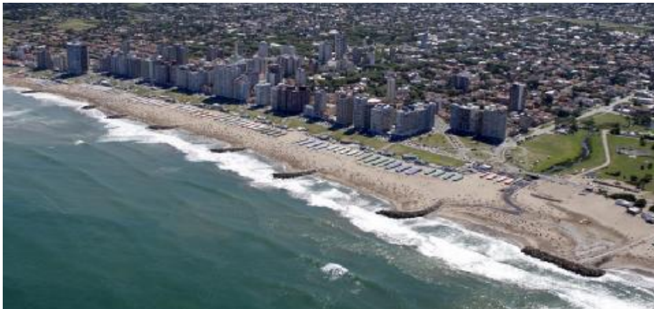
Imagen VI.30. Aspecto actual de las obras de defensa costera construidas a principios de los 80' en Miramar. En la misma fotografía puede observarse el "paredón" edilicio en el frente costero urbano-turístico.
