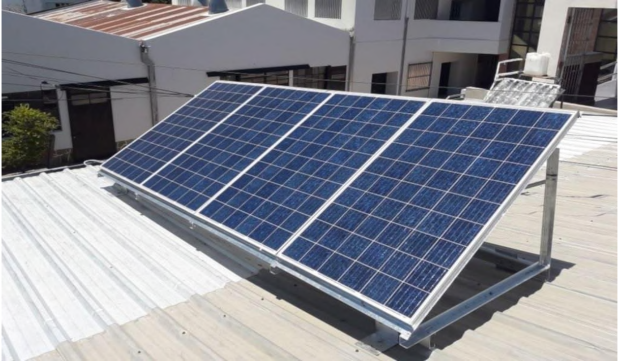
Imagen 3- Ejemplo de instalación FV con 4 paneles en una vivienda:
