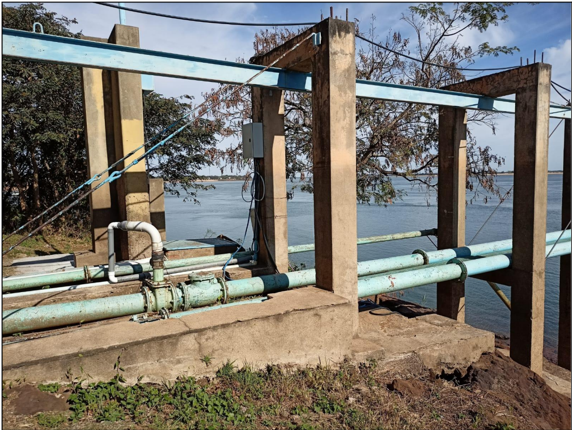
Figura 12. Muelle de toma. (Fuente: Elaboración propia).
