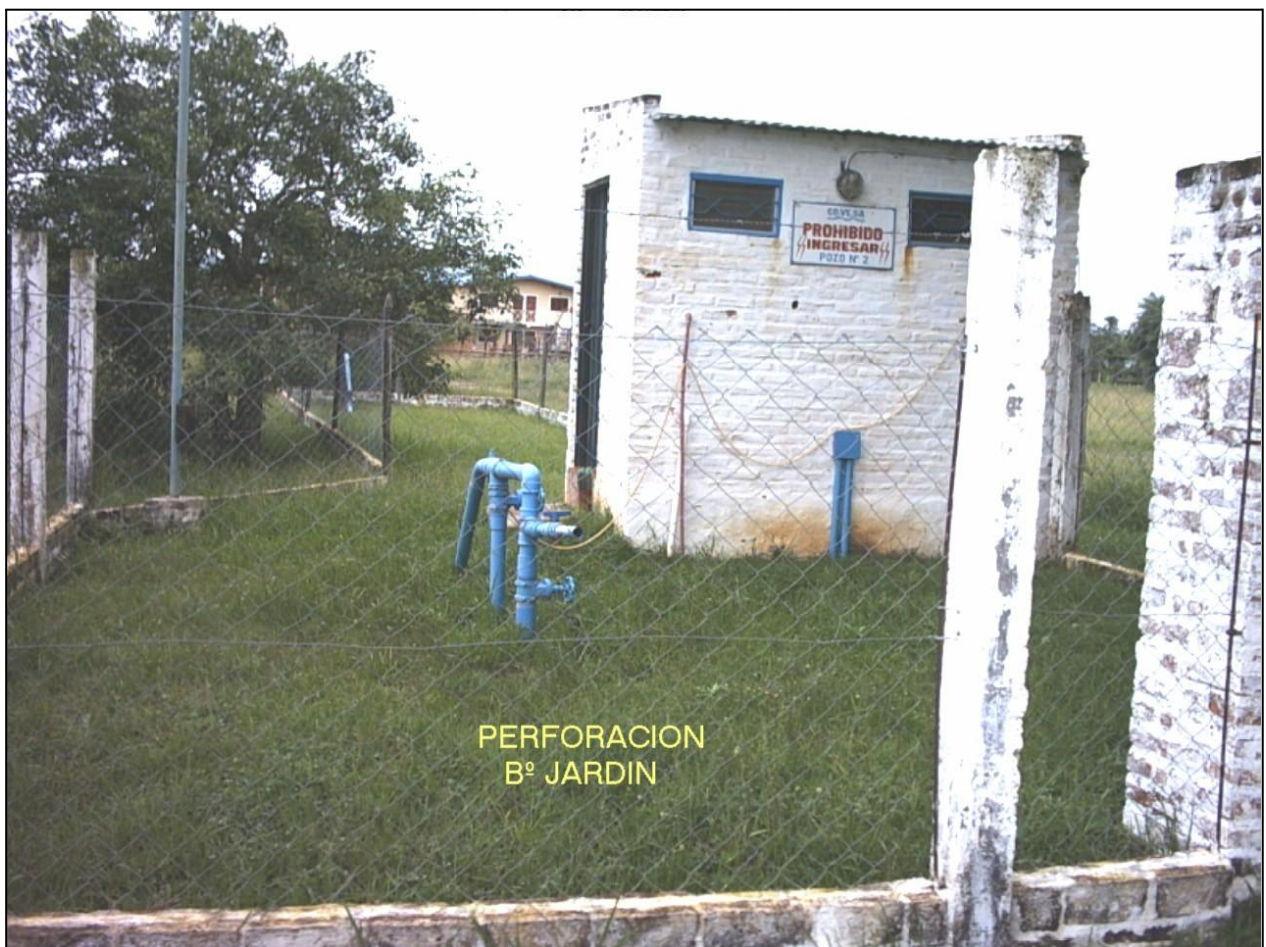
Figura 10. Perforación Barrio Jardín. (Fuente: Aguas de Corrientes).
