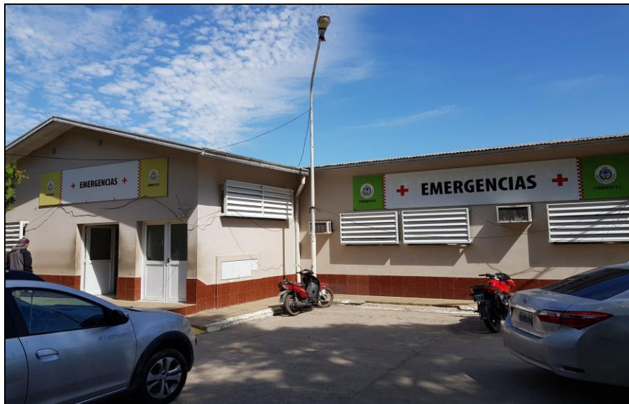
Figura 4: Vista de la entrada de Emergencias del Hospital Llano
