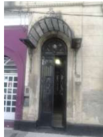
Alero de puerta de acceso a vivienda sobre calle Salta al 1000.
