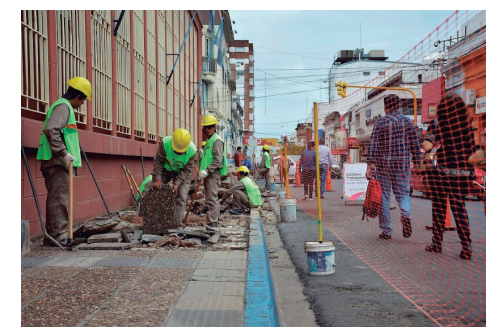
Obra de veredas accesibles sobre calle Córdoba. Fuente: Municipalidad de Corrientes
