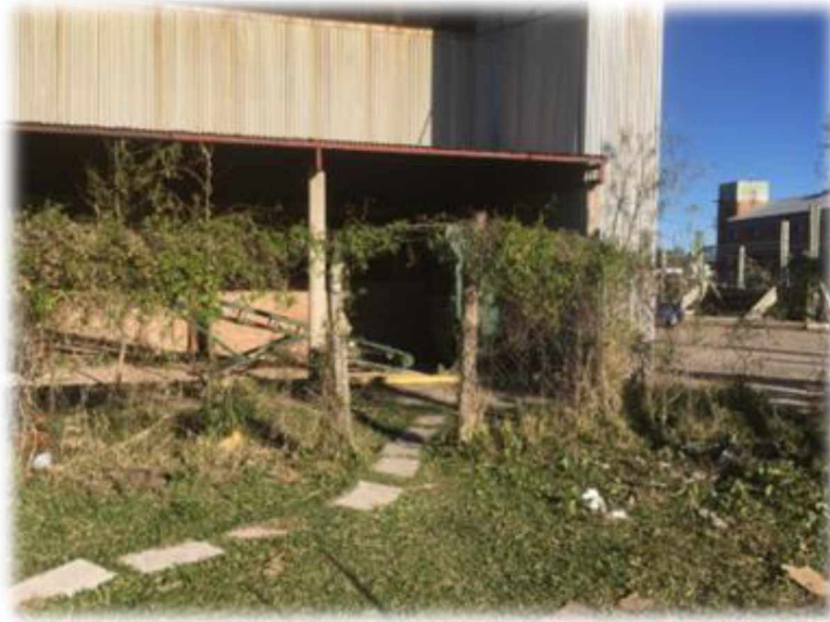
Figura 26. Actual acceso entre el nuevo campus de electromecánica y el túnel de viento. Fuente: Obtención propia
