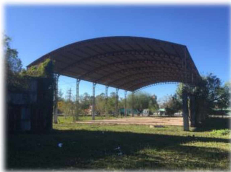
Figura A1. Tinglado campus Túnel del Viento. Fuente: Obtención propia
