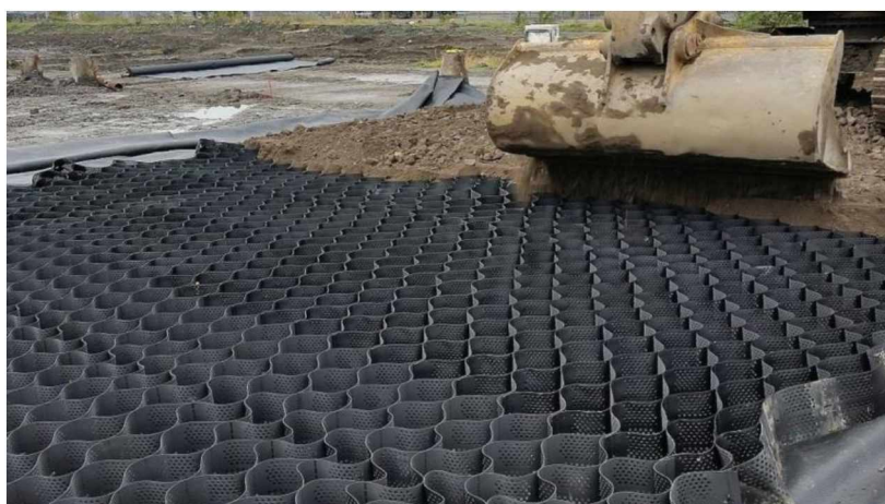
Figura 96. Panel de geoceldas (Fuente: Tecno materiales S.A.)
