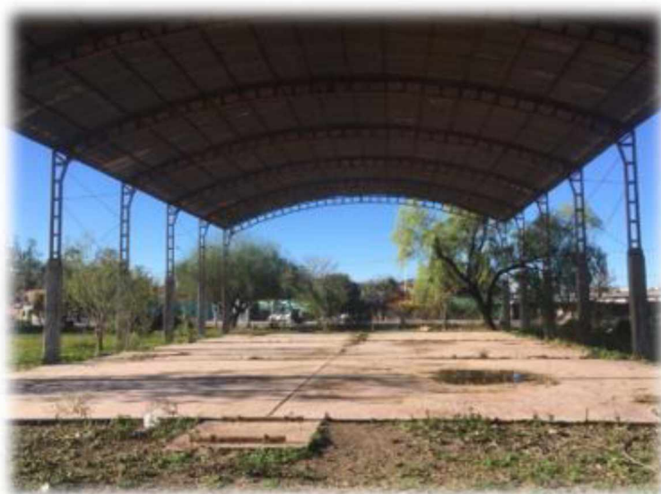
Figura A2. Tinglado campus Túnel del Viento. Fuente: Obtención propia
