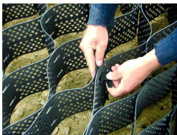
Figura 97. Panel de geoceldas (Fuente: Tecno materiales S.A.)
