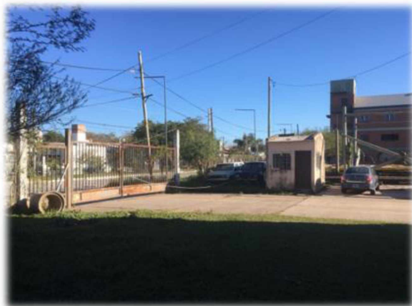
Figura 22. Acceso principal al Túnel de viento (Calle Duvivier) y garita de seguridad. Fuente: Obtención propia
