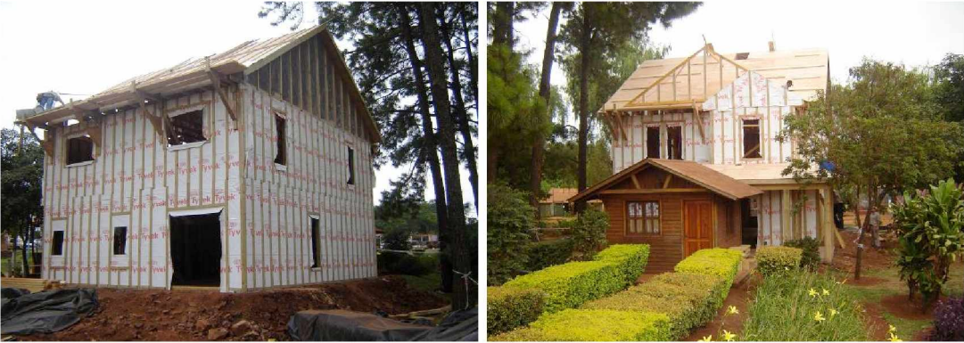
Figura 1 y 2: Imágenes del prototipo en la fase final de construcción. Fuente: Sánchez Soloaga, Iris. Fotografías tomadas durante el seguimiento de la obra.
