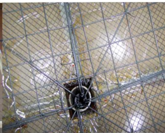
Fig. 3.2 – Detalle de la armadura
