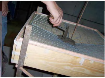
Fig. 3.6 – Aisando la mezcla
