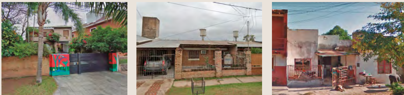
Fotos ilustrativas de espacios abiertos de las viviendas en los C3, C2 y C1
