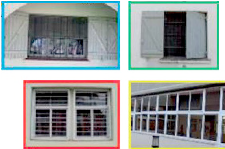
Figura 11. Carpinterías externas en aventanamientos del edificio de la FAU, factor fundamental en el aporte de luz natural
