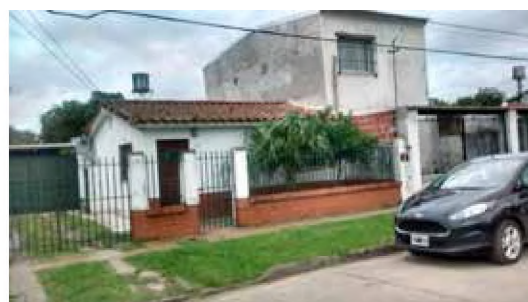
Figuras 3 y 4. Viviendas del barrio con la imagen original en la volumetría, caracterizada por la utilización de losa de hormigón armado en pendiente con tejas coloniales. Fuente: colección del autor.
