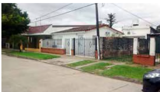
Figuras 3 y 4. Viviendas del barrio con la imagen original en la volumetría, caracterizada por la utilización de losa de hormigón armado en pendiente con tejas coloniales. Fuente: colección del autor.
