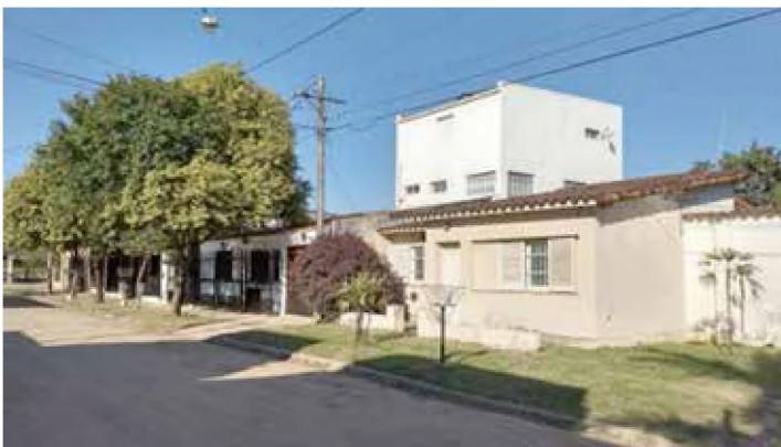
Figura 6. Algunas de las viviendas definen modificaciones al modelo inicialmente construido. Fuente: colección del autor
