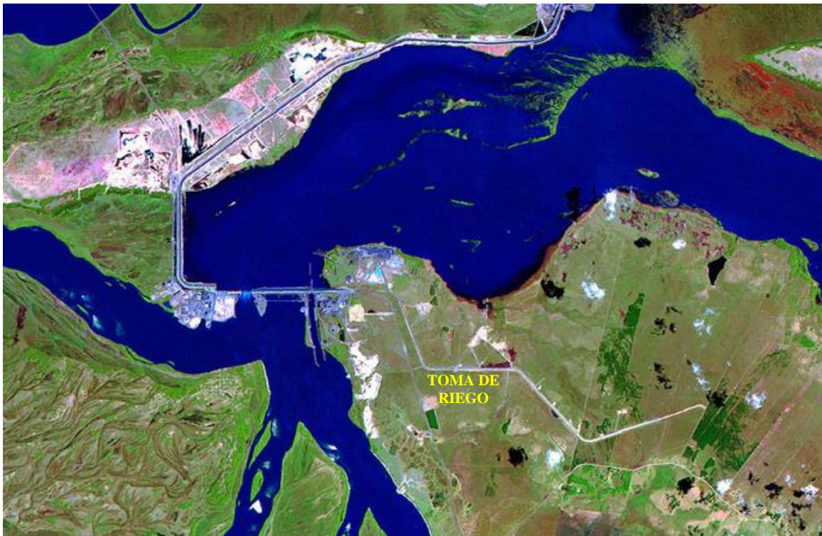
Fuente : ATLAS GEOGRÁFICO DE LA REPUBLICA ARGENTINA – INSTITUTO GEOGRÁFICO MILITAR Imagen de la Represa en donde se observa la traza del cierre de margen izquierda sin el llenado final del embalse (Cota 76) y la toma de riego en la Provincia de Corrientes
