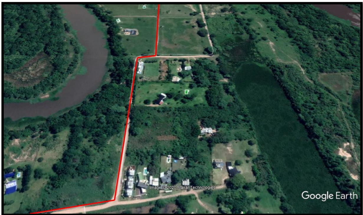
Imagen 8. Calle Padre Distortio desviación de 40,00m con respecto al eje (Fuente: Elaboración propia con base en Google Earth).
