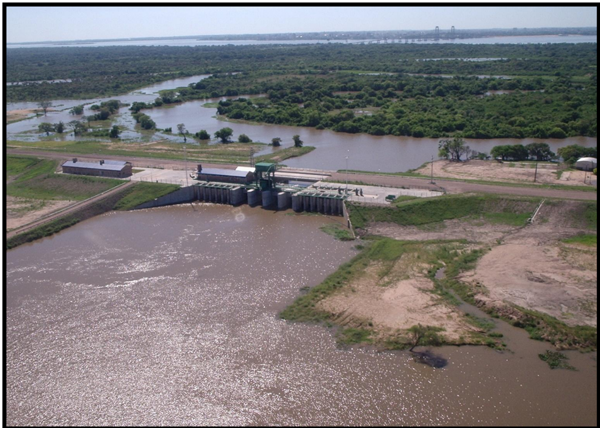
Imagen 22. Estación de bombeo (Fuente: Google imágenes).
