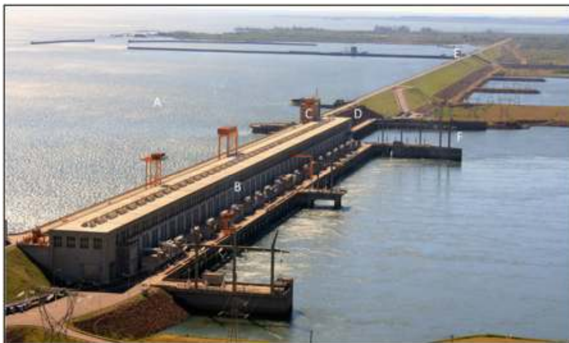
Figura 3. Central Hidroeléctrica Yacyretá (vista desde margen derecha). A. Embalse. B. Central. C. Ascensor de peces (IPP). D. Vertederos. E. Esclusa. F. Pileta de quietamiento.
