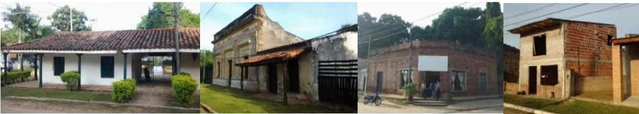
Fig. 3: Ejemplo de la evolución en los últimos 100 años de la edificación argentina: de construcciones con adobe y madera (izquierda) a las de cerámicos huecos, chapas y vidrio (derecha). De altas a bajas resistencias térmicas perimetrales de la edificación . Fuente: JACOBO, 2016 y 2017.
