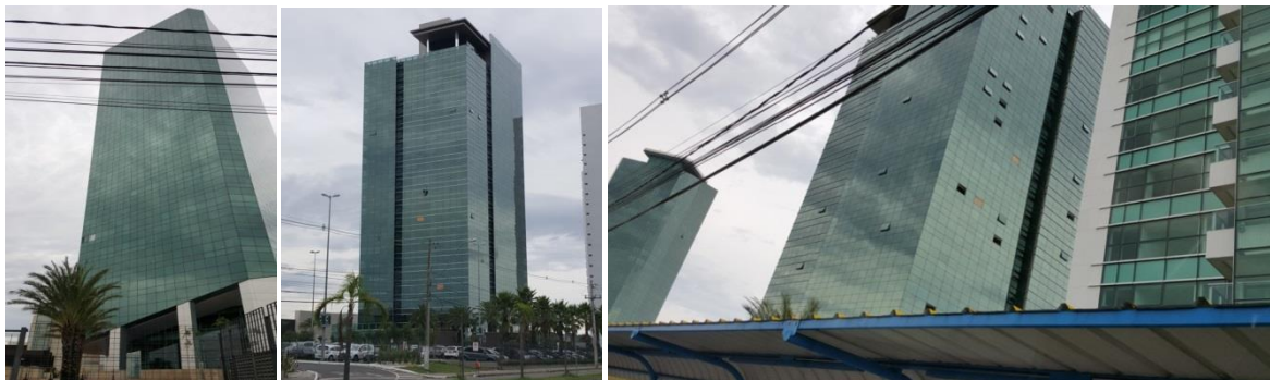
Figura 11. Danos a elementos de revestimento: algumas janelas que não estavam trancadas foram destruídas.
