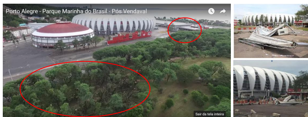
Figura 10. Danos a árvores e estruturas vizinhas causados pelo downburst e nenhum dano ao estádio.
