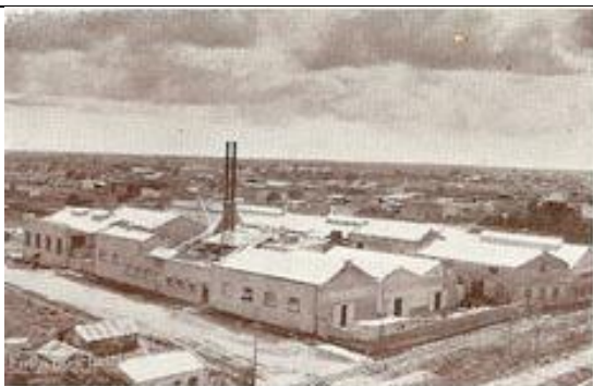
Vista aérea del Establecimiento fabril instalado en Resistencia, próximo a la estación del F. C. C. N. A.
