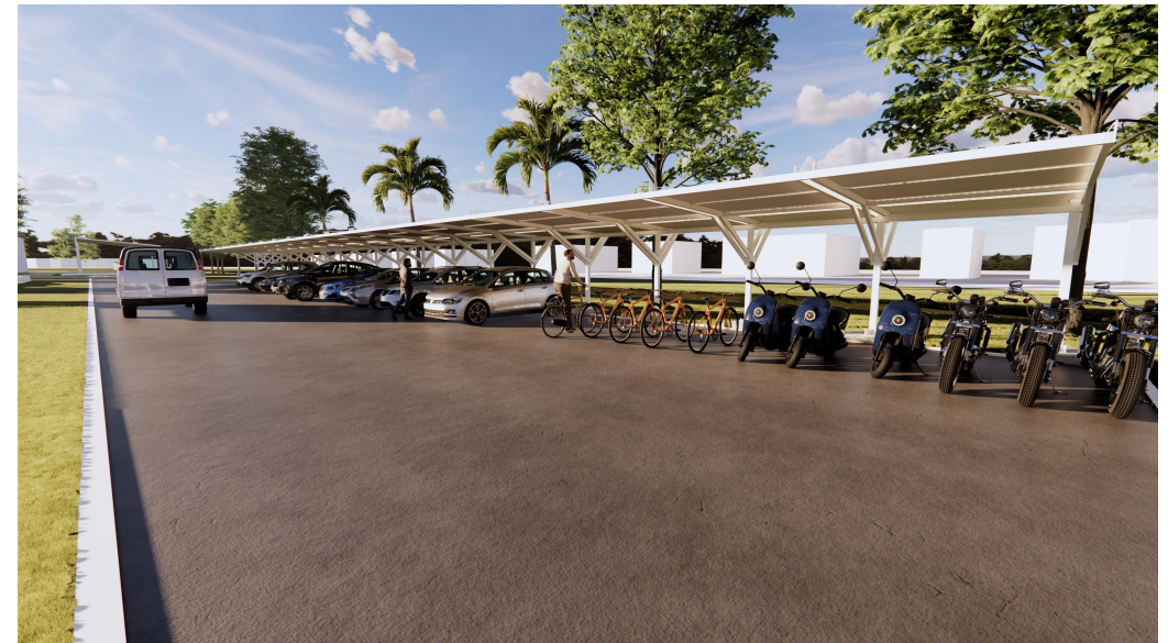
Imagen: Estacionamiento PP2 / PP3. Fuente: Elaboración propia, 2022.
