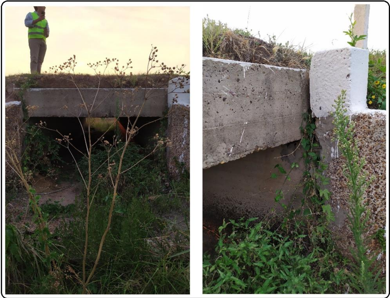
Figura 1.9 – Estado de conservación y mantenimiento de las alcantarillas – Fuente: Relevamiento del grupo.
