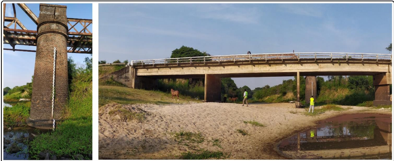
Figura 6.11 – Escala hidrométrica en la sección puente del A° San Lorenzo – Fuente: Relevamiento del grupo.
