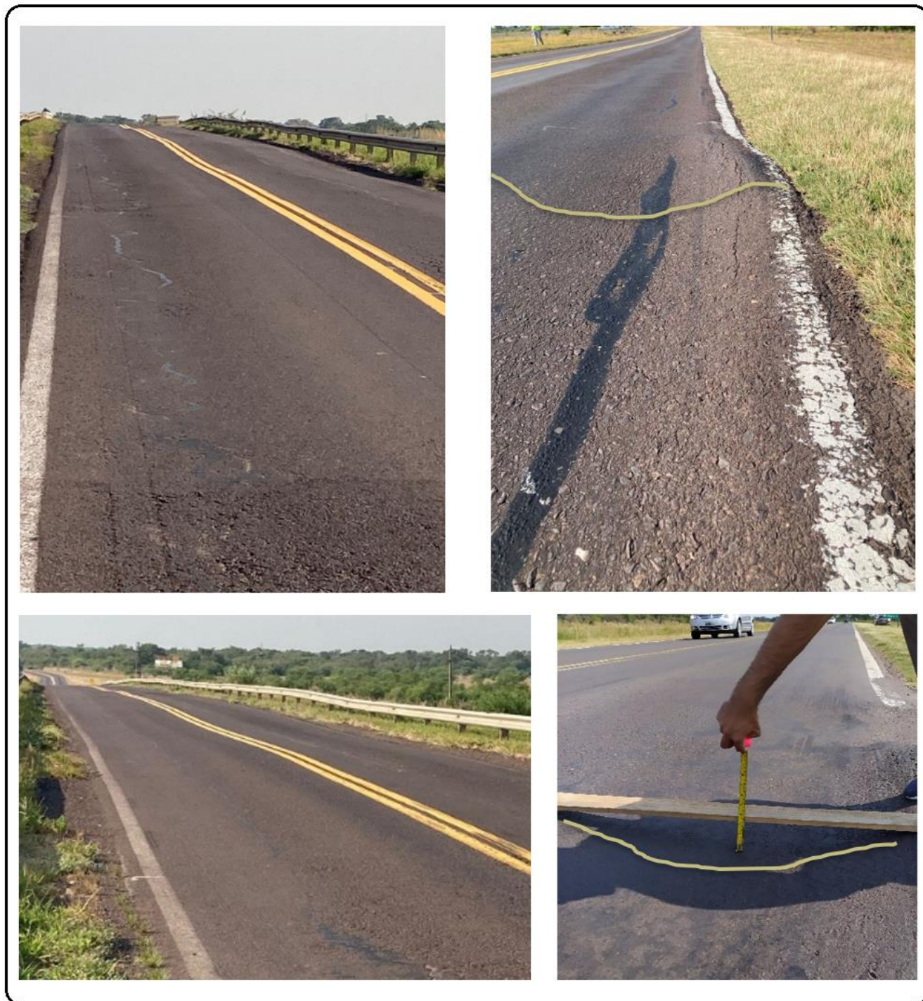
Figura 1.5 – Deformaciones longitudinales y transversales – Fuente: Relevamiento del grupo.
