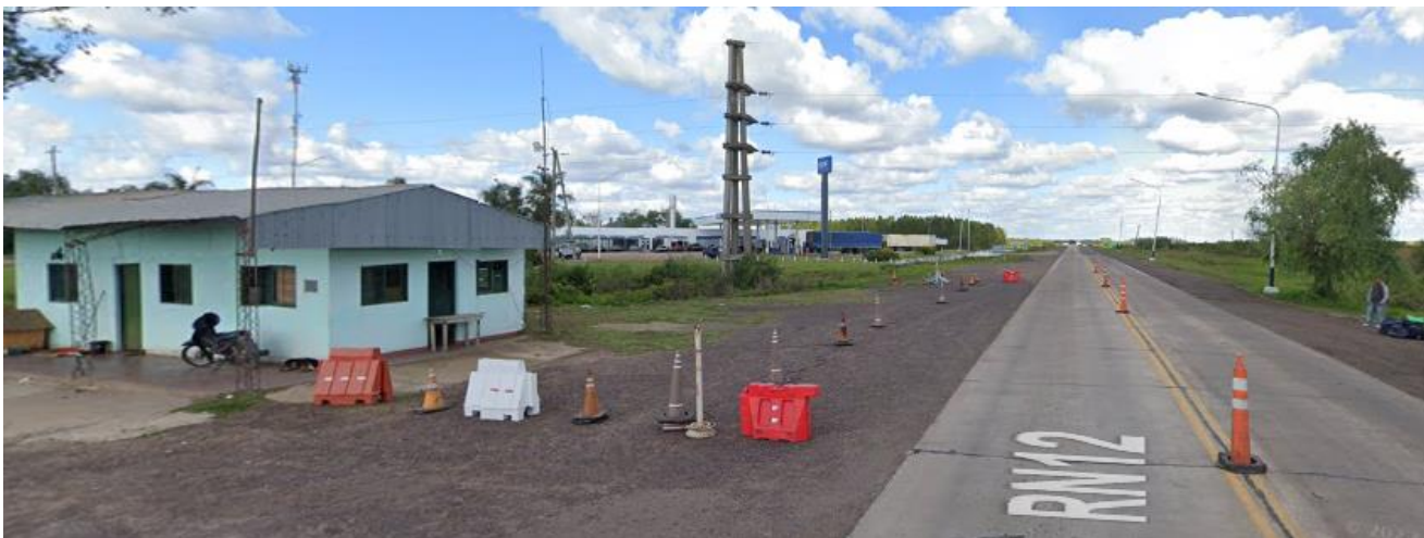
Figura 7.9 - Intersección RN12 (Descendente) – RP27 – RN 118 (Cuatro Bocas) – Fuente: Google Earth
