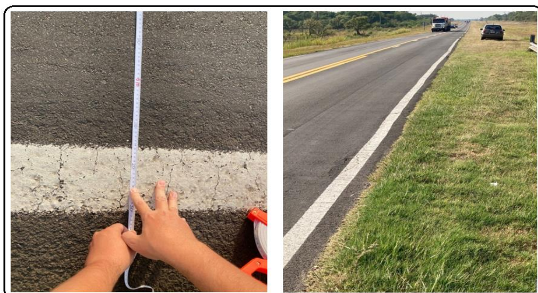
Figura 1.4 – Ancho de calzada y banquina de tierra – Fuente: Relevamiento del grupo.
