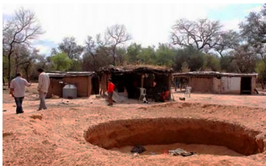
Figura 18. Pozo para instalación de una cisterna en Nueva Pompeya (Informe diagnóstico hacia soluciones habitacionales en el Gran Chaco, 2016).
