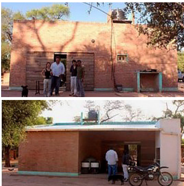
Figura 33. Espacio de integración en un prototipo de un programa de vivienda. La apertura del portón permite la integración del estar, comedor y cocina con la galería y el exterior (Informe diagnóstico hacia soluciones habitacionales en el Gran Chaco, 2016).
