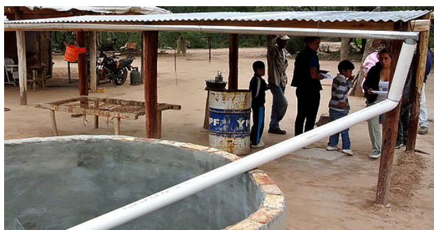
Figura 5. Ejemplo de recolección de agua de lluvia por aljibes (Informe diagnóstico hacia soluciones habitacionales en el Gran Chaco, 2016).
