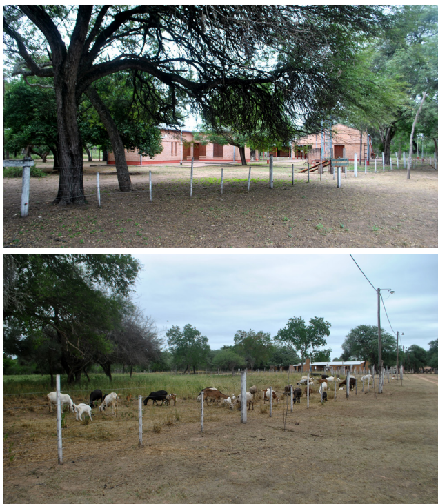
Figura 8. Instalaciones del CEDEPRO ubicado en cercanías de Misión Nueva Pompeya. Fotografía: María Noel Depettris.
