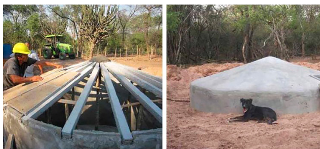
Figura 6. Cisternas de placas de cemento realizadas por el INTA (Informe diagnóstico hacia soluciones habitacionales en el Gran Chaco, 2016).
