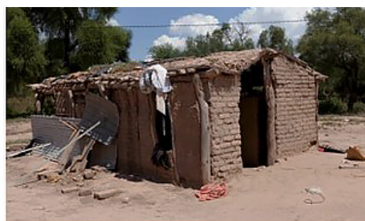
Construcción de vivienda con cerramiento de bloques de adobe y estructura independiente de horcones.
