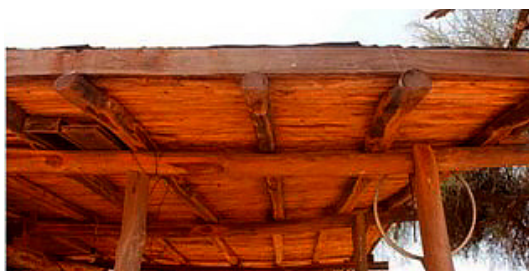
Figura 23. Techo de torta de barro mejorado (Informe diagnóstico hacia soluciones habitacionales en el Gran Chaco, 2016).
