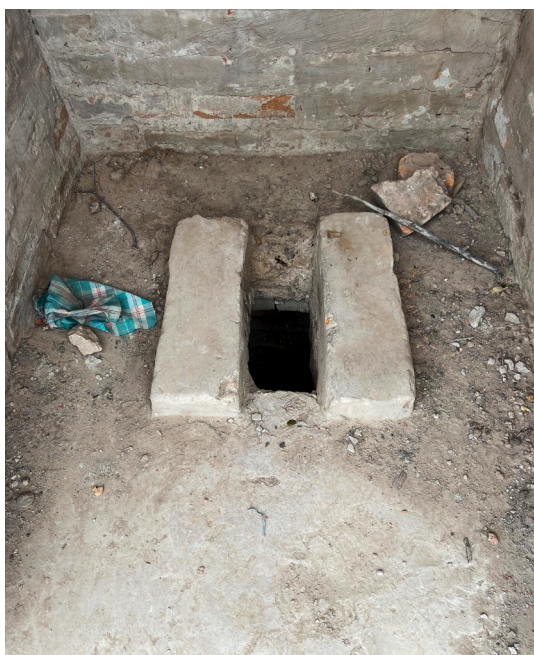
Figura 10. Baño con descarga directa a pozo ciego (paraje Nueva Población). Fotografía: Hugo Zurlo.
