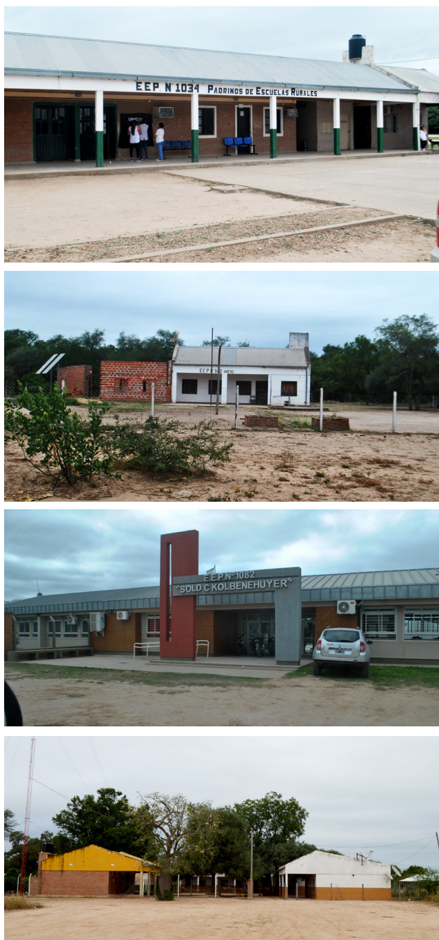
Figura 16. Distintos edificios escolares de educación inicial y primaria: A. EEP N° 1034 en zona rural de Miraflores. B. Anexo escolar (plurisala) de la EEP N° 362 del paraje La Armonía, cercano a Miraflores. C. EEP N° 1082 de Misión Nueva Pompeya. D. EEP (sin identificar) en paraje cercano a Misión Nueva Pompeya. Fotografías: María Noel Depettris y Evelyn Abildgaard.
