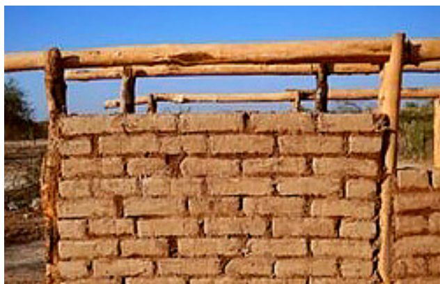
Figura 20. Etapas constructivas de una unidad doméstica vernácula (Informe diagnóstico hacia soluciones habitacionales en el Gran Chaco, 2016).
