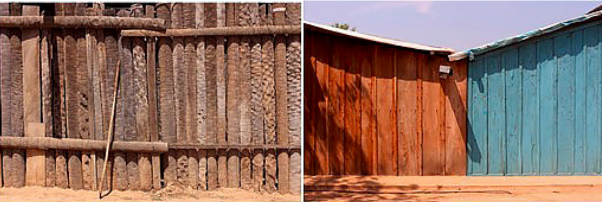
Figura 28. Cerramientos laterales de madera. Izq. Vivienda construida con sistema de maderas de palma. Der. Vivienda construida con sistema de tabloncillos de madera (Informe diagnóstico hacia soluciones habitacionales en el Gran Chaco, 2016).
