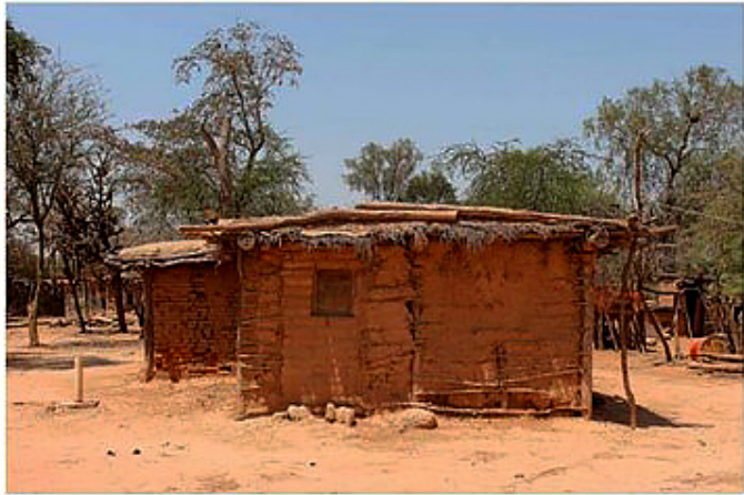
Figura 26. Cerramientos laterales de estanteo/quincha (Viñuales, 2003, cito en Informe diagnóstico hacia soluciones habitacionales en el Gran Chaco, 2016).
