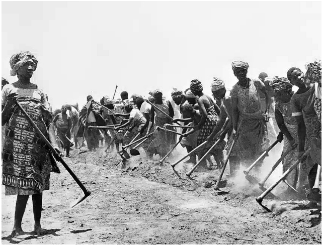
Figura 12. Prácticas en la infraestructura de las aldeas UJAMAA (Fotografía s/f).
