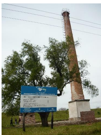
1- Chimenea Codutti. Puerto Vilelas. Fuente:MPM Julio 2015
