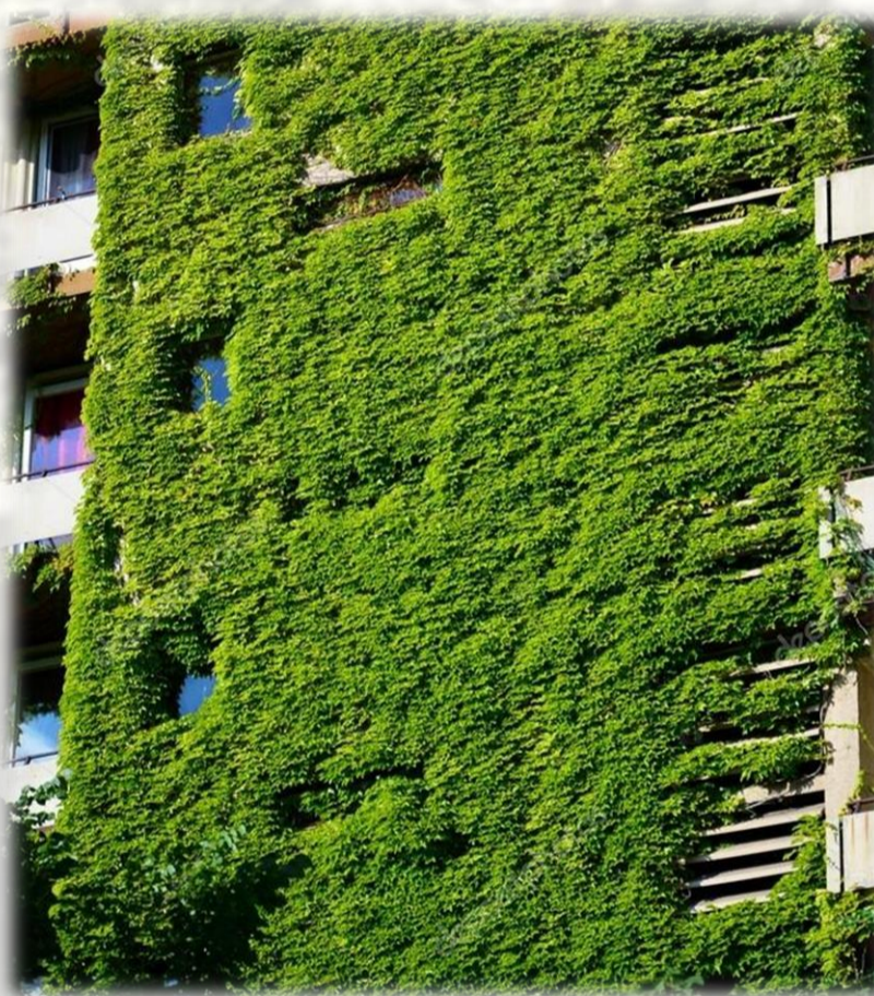
Los recursos optados son el de implementar dos módulos de muro verde sobre el paramento al mismo tiempo que se arboriza el patio, ambos como barreras naturales para la incidencia solar proveniente desde el Oeste.
