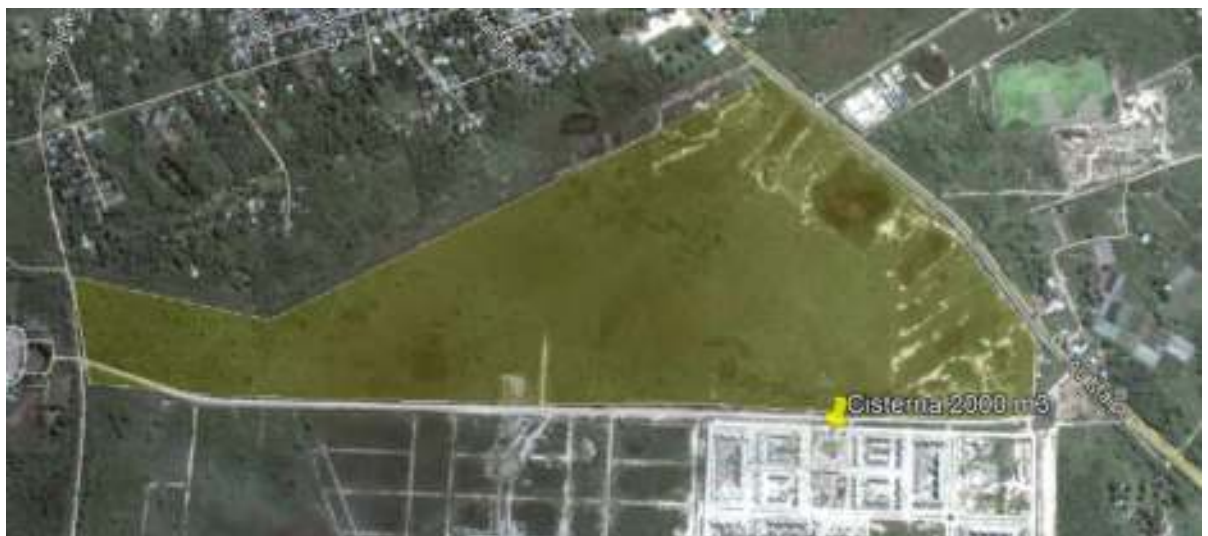
Figura 61. Ubicación de Cisterna del predio Santa Catalina (fuente: Aguas de Corrientes).
