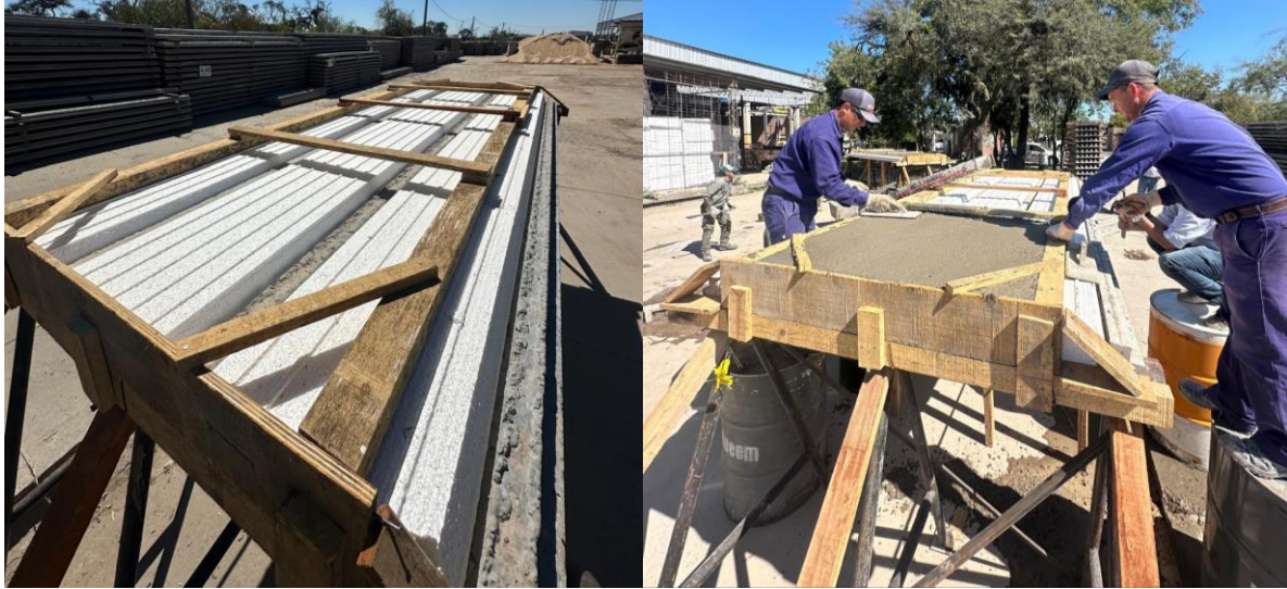
Fig. 2.16 Forjado N° 2 con HRF
