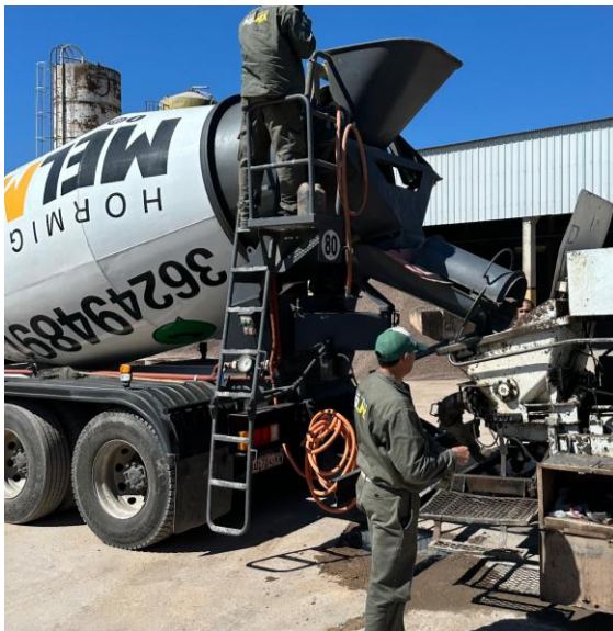
Fig. 1.12 - Equipo de bombeo utilizado (Hormigones Melmix)
