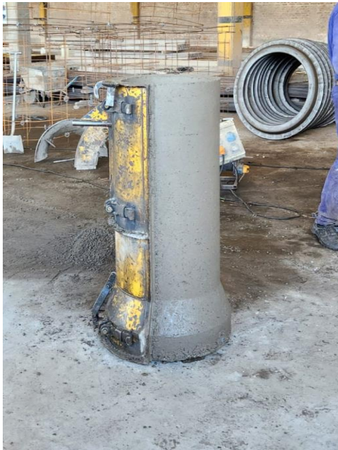
Fig. 3.15 - Desmolde de los tubos
