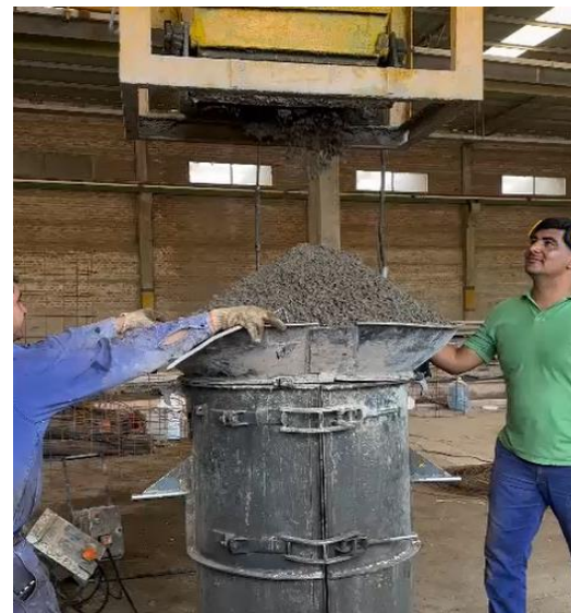
Fig. 3.14 - Vibrado del hormigón
