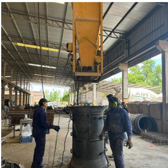
Fig. 3.13 - Colado del hormigón
