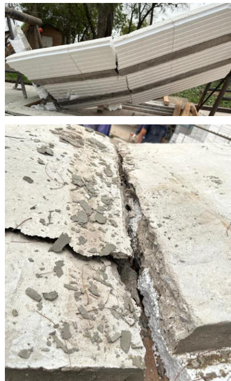
Fig. 2.24 Modo de rotura por flexión forjado N1.
