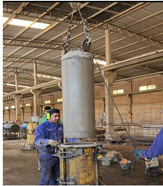
Fig. 3.16 - Extracción de molde interno
