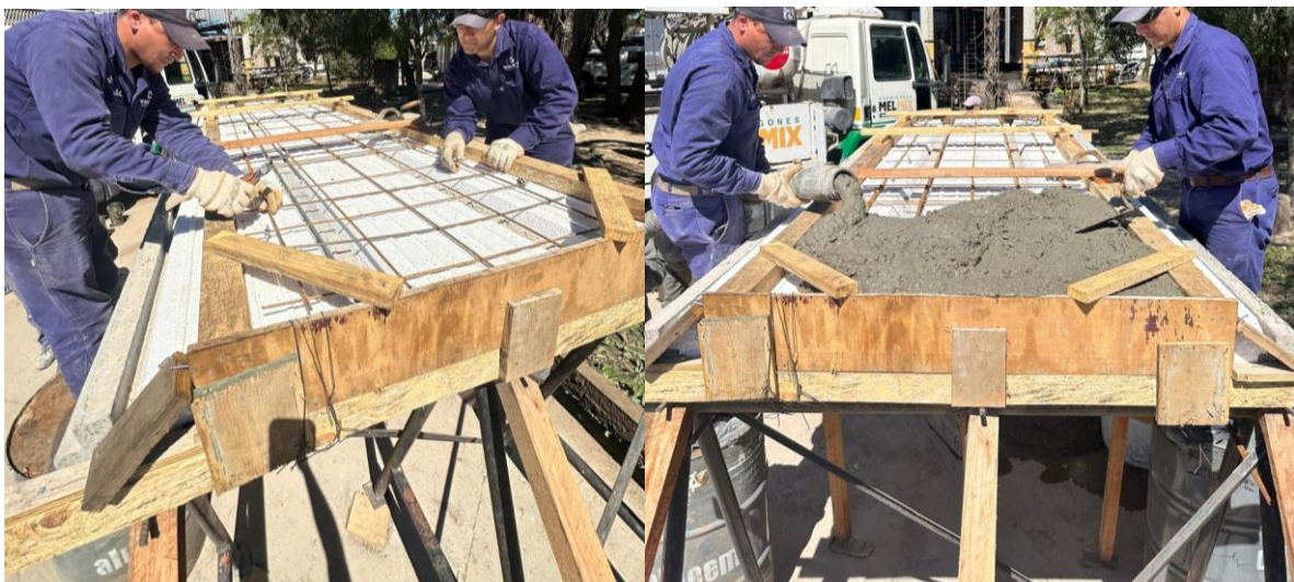
Fig. 2.15 Forjado N° 1 con malla
