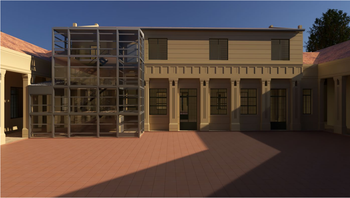
FOTO N°28: Fachada sur del patio cubierto y aulas.
