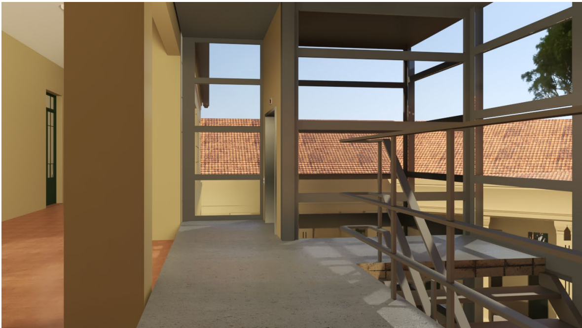
FOTO N°27: Escalera, ascensor y pasillo.
