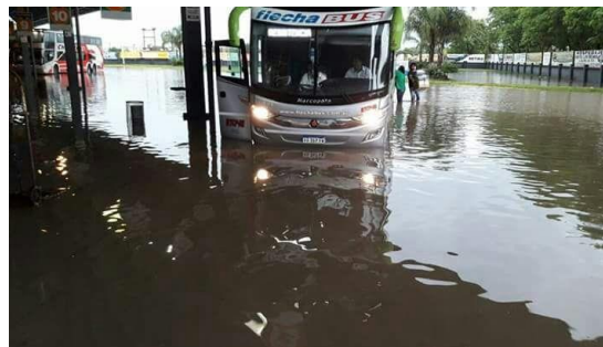
Figura II-14. Sector dársenas de la ETOR inundada (fuente: Diario Norte, 2017)
