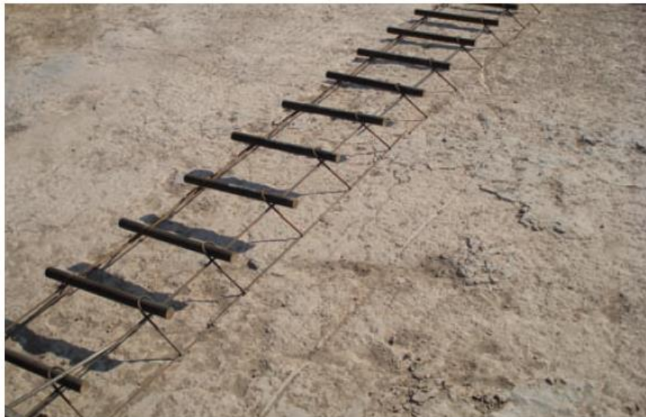
Figura VI-35. Colocación de canastos. (Fuente: ICPA).
