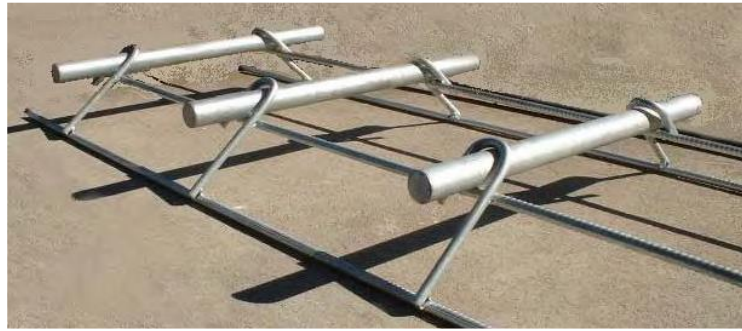
Figura VI-36. Colocación de canastos. (Fuente: Cátedra Transporte III .U.N.R.)
