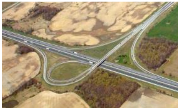
Figura 45. Distribuidor en trompeta
