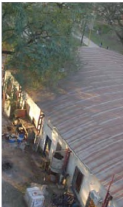
Vista de la cubierta
