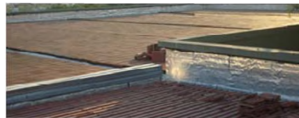
Vista de la cubierta
